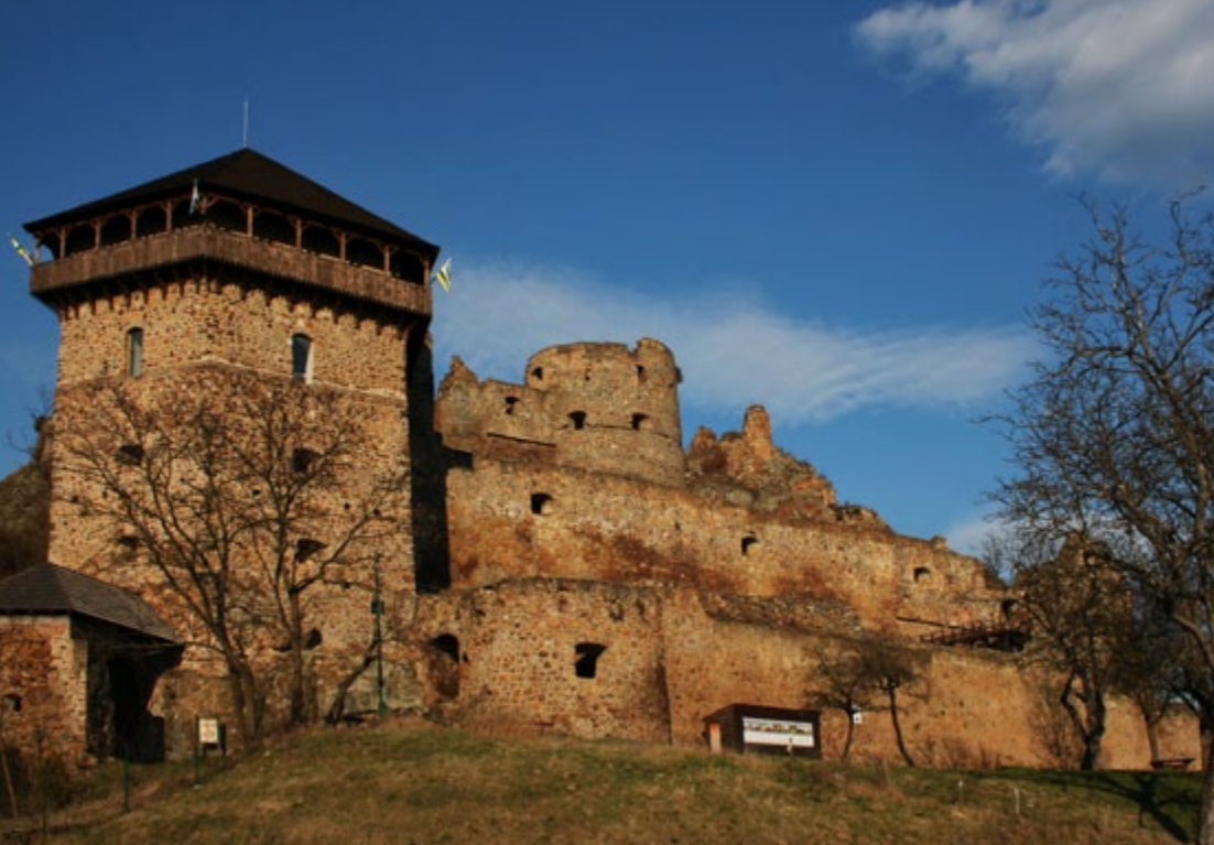
Flakovsky hrad - bývalé sídlo jediného tureckého sandžaku v SR
