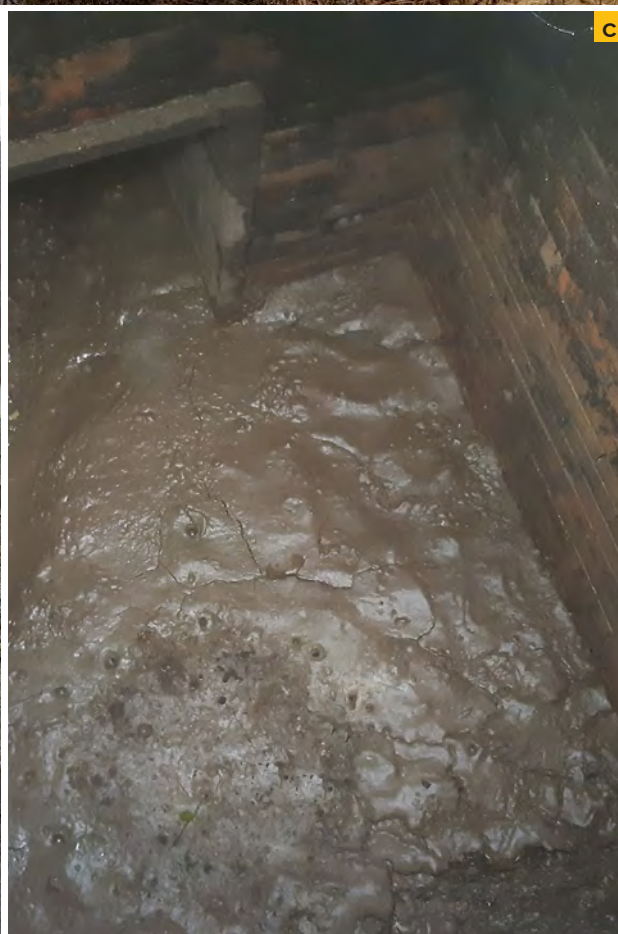
12 a) Premostenie kanála ponad Malý Dunaj b) Manipulačná šachta na severnom brehu Malého Dunaja c) Chemicky zápachajúce bahno v manipulačnej šachte
