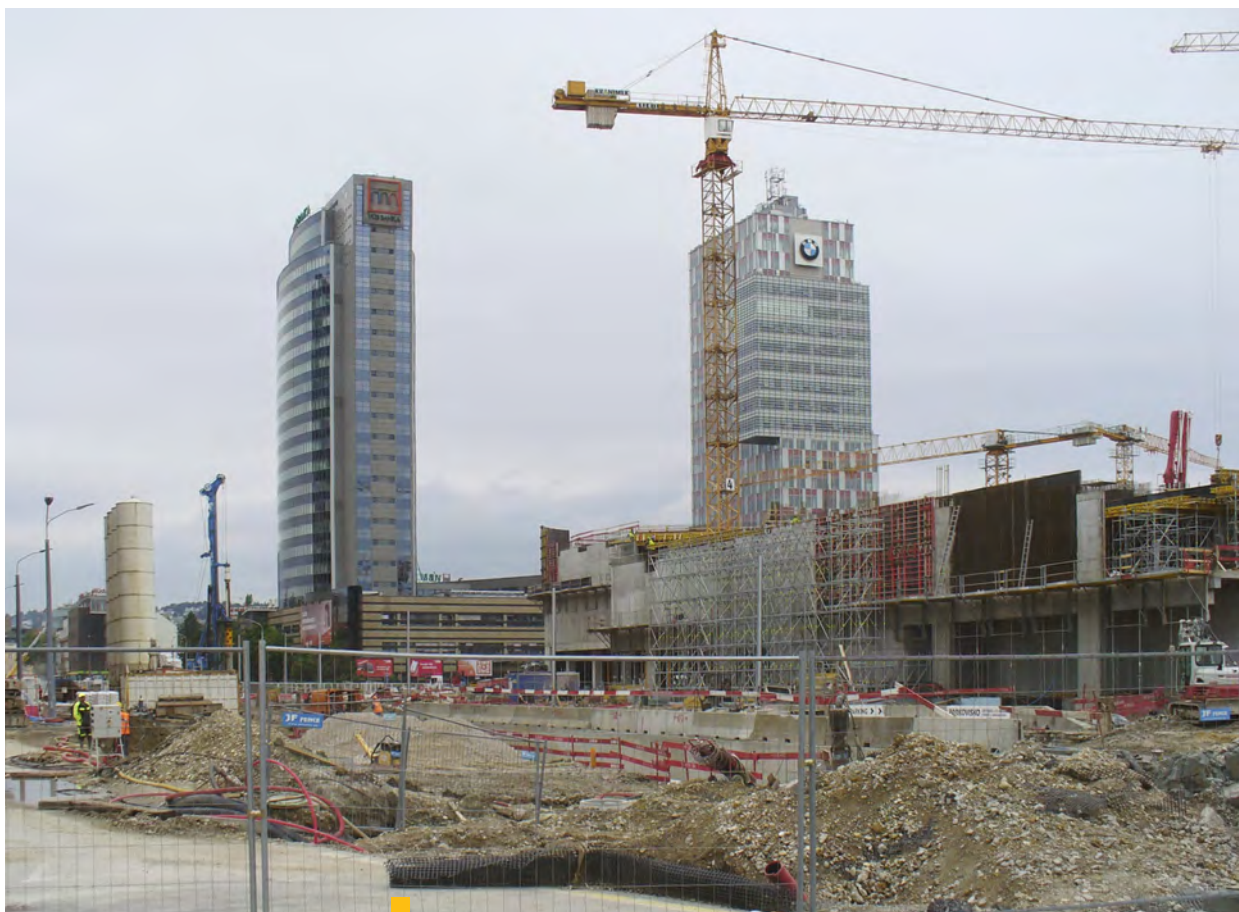
2 Výstavba v oblasti Twin City Sever
