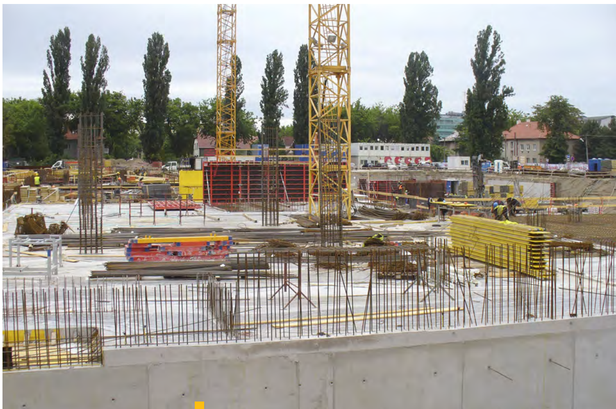
6 Výstavby polyfunkčného objektu KLINGERKA 2 – 3
