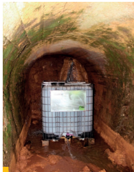
2 Pasívny systém čistenia banských vôd umiestnený v portáli štôlne Agnes
