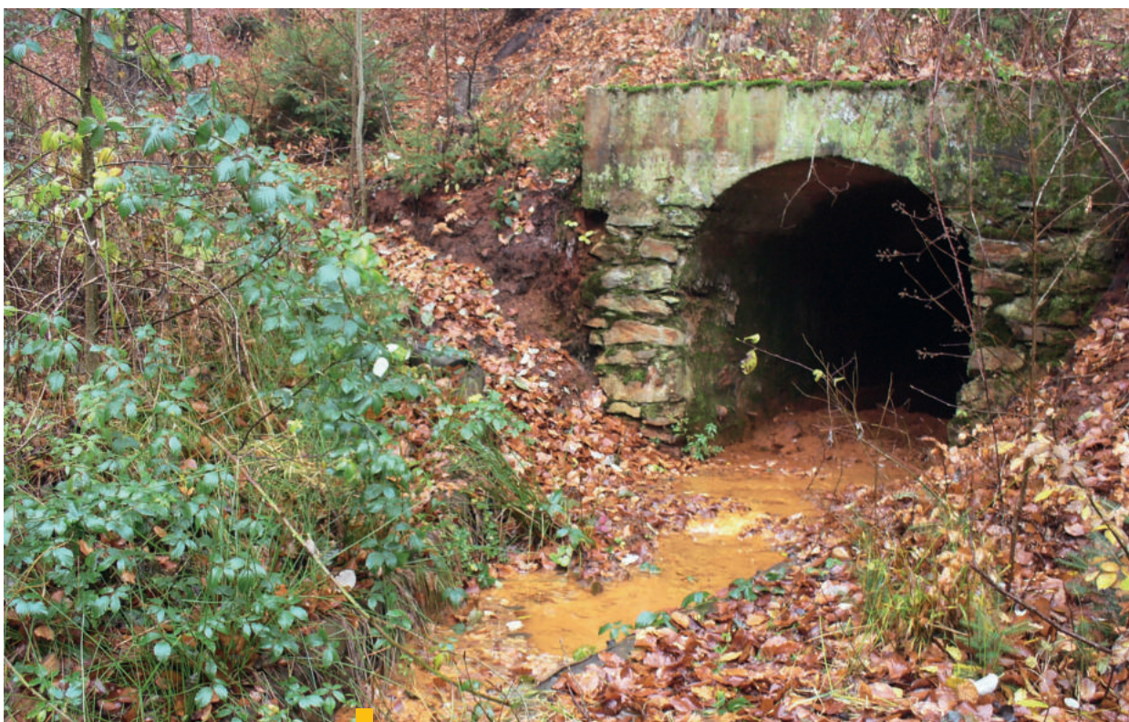
11 Banská lokalita Poproč-Petrova dolina – opustené ložisko antimónových rúd. Ťažba Sb rudy sa začala v 17. storočí a definitívne bola ukončená v roku 1965. Štôlna Agnes s výtokom banských vôd s precipitáciou Fe okrov obsahmi As a Sb. V portáli štôlny sa od roku 2013 realizoval pilotný projekt pasívnej geochemickej bariéry na čistenie banských vôd.
