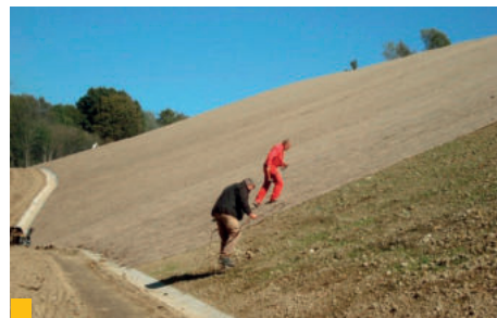
6 Ukladanie biodegradovateľnej rohože
