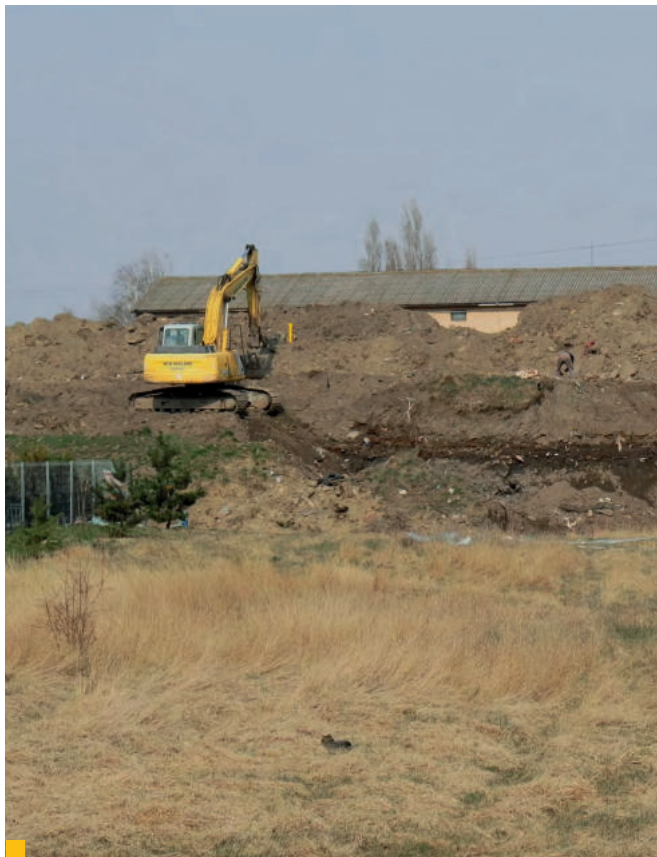
7 Začiatok sanačných prác | zdroj: MŽP SR
