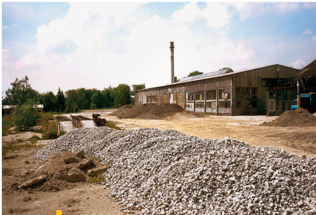
18 Garážové dvory pred sanáciou | zdroj: ISEZ
