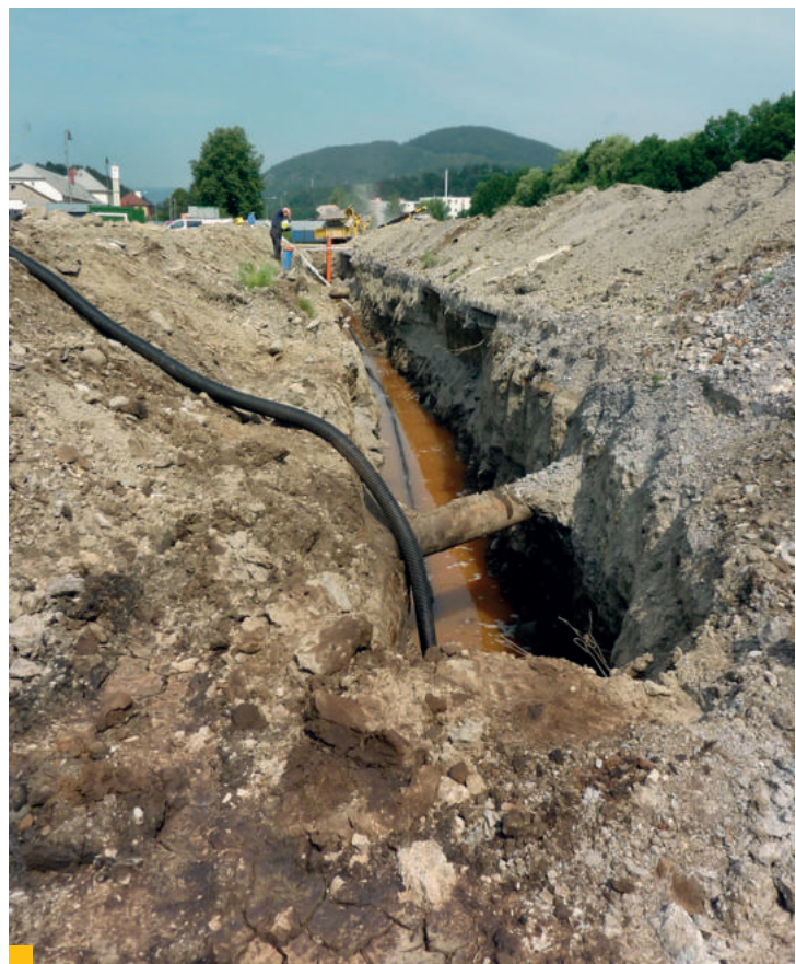
10 Sanácia znečistených zemín in situ | zdroj: MŽP SR
