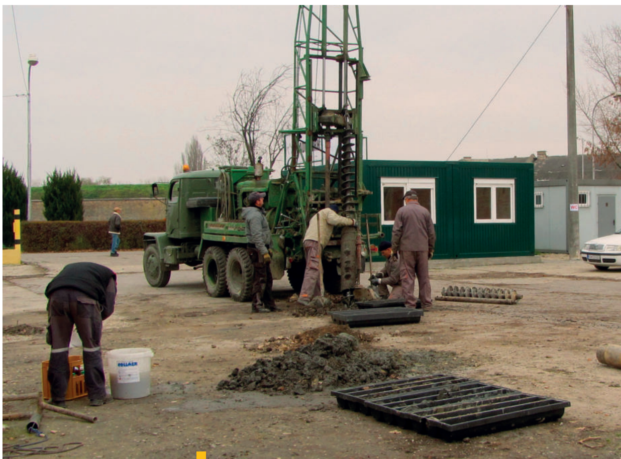
9 Oblasť Autopark I – vrtné práce
