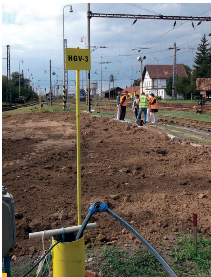
17 Záber z kontrolného dňa počas sanácie
