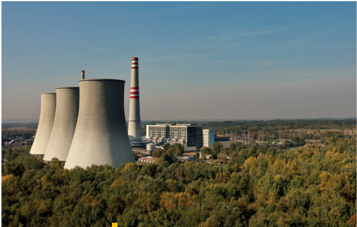
1 Pohľad na areál Elektrárne Vojany
