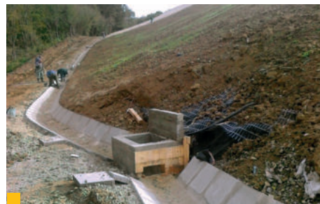
7 Kontrolná šachta 2 – dolný rigol
