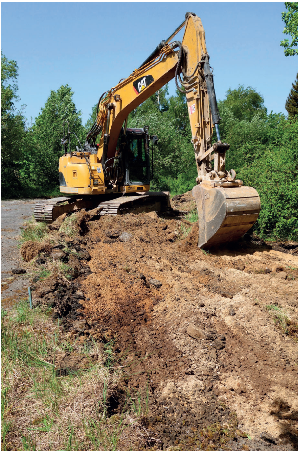
Odstraňovanie znečistenej zeminy počas sanačných prác v lokalite Lešť (vojenský obvod) – Garážové dvory
