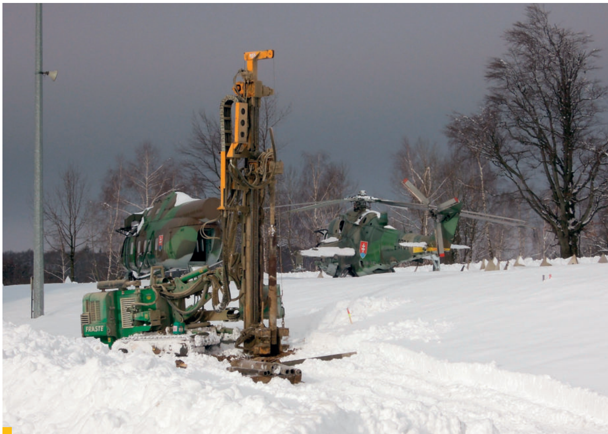
21 Realizácia prieskumných sond vrtnou súpravou Fraste v pedsanačnej etape | foto: J. Schwarz, január 2015
