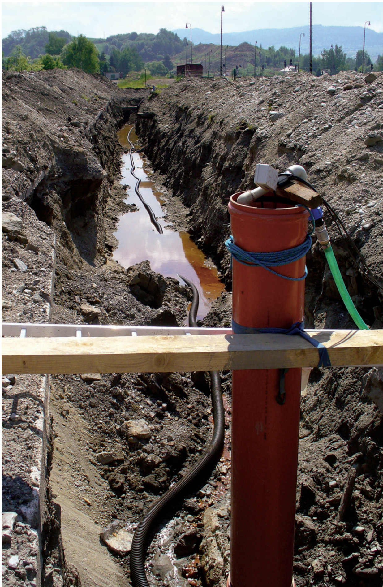
Brezno – železničná stanica – sanácia znečistených zemín in situ
