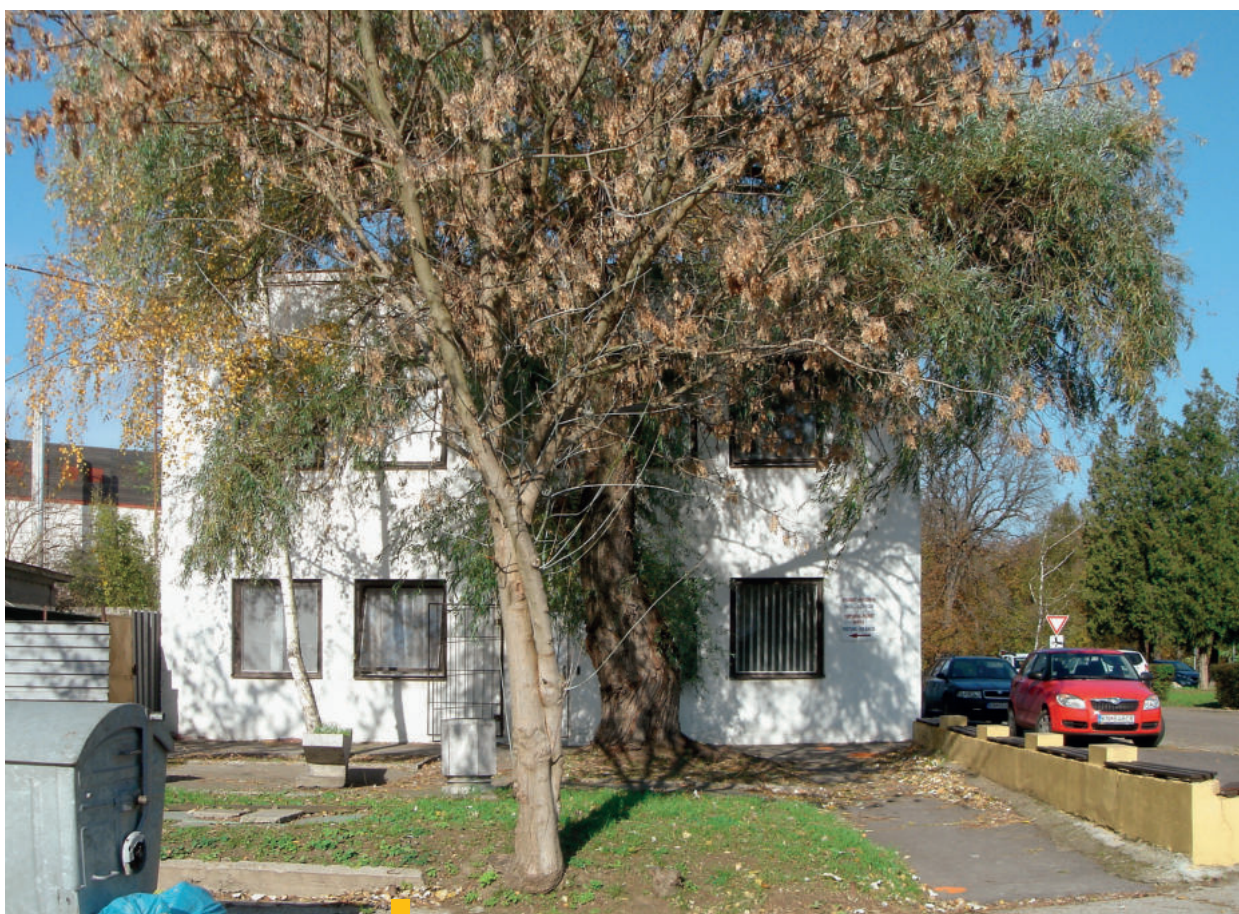
3 Oblasť Autopark I – budova Mestskej polície
