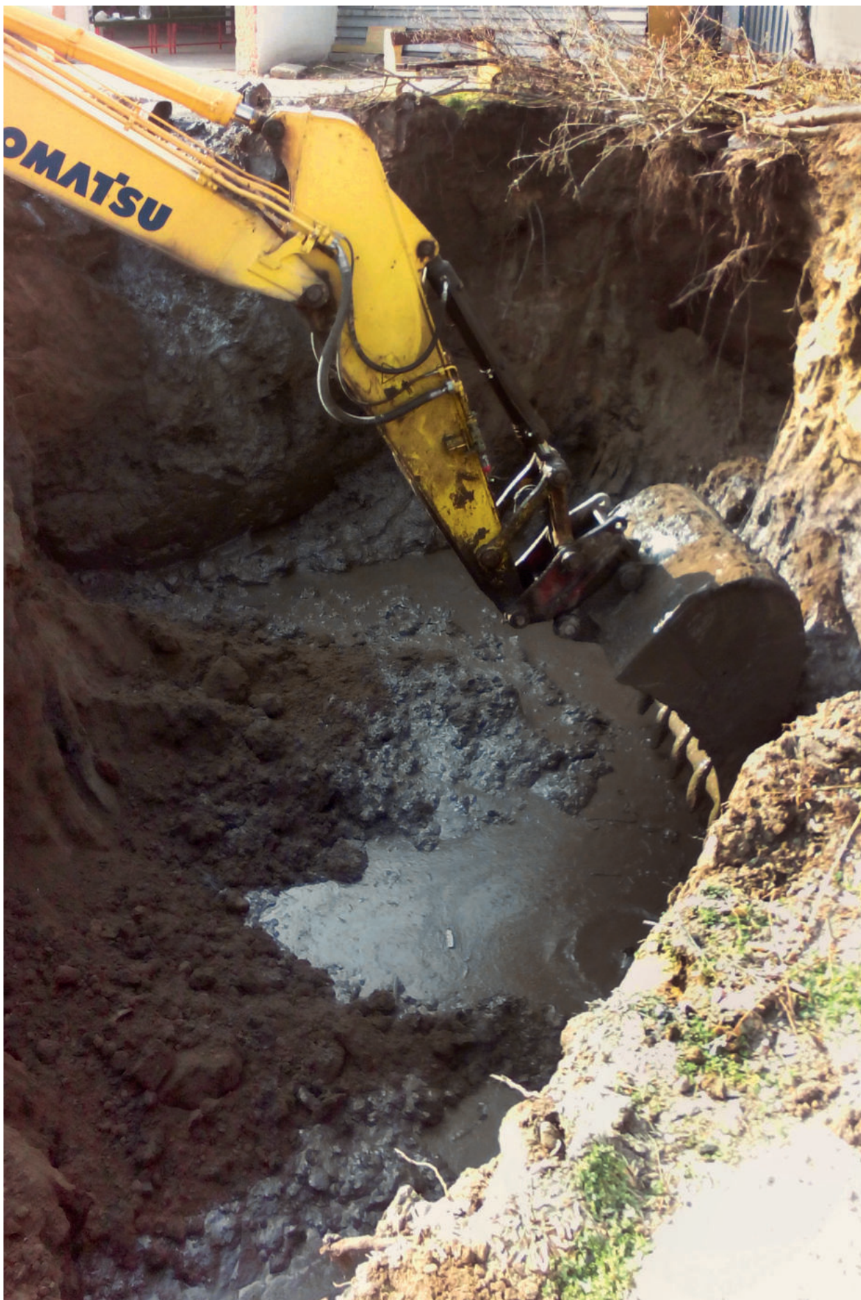
Odťažba znečistených zemín počas sanácie zemín ex situ v lokalite Komárno – areál po Sovietskej armáde, oblasť Autopark I
