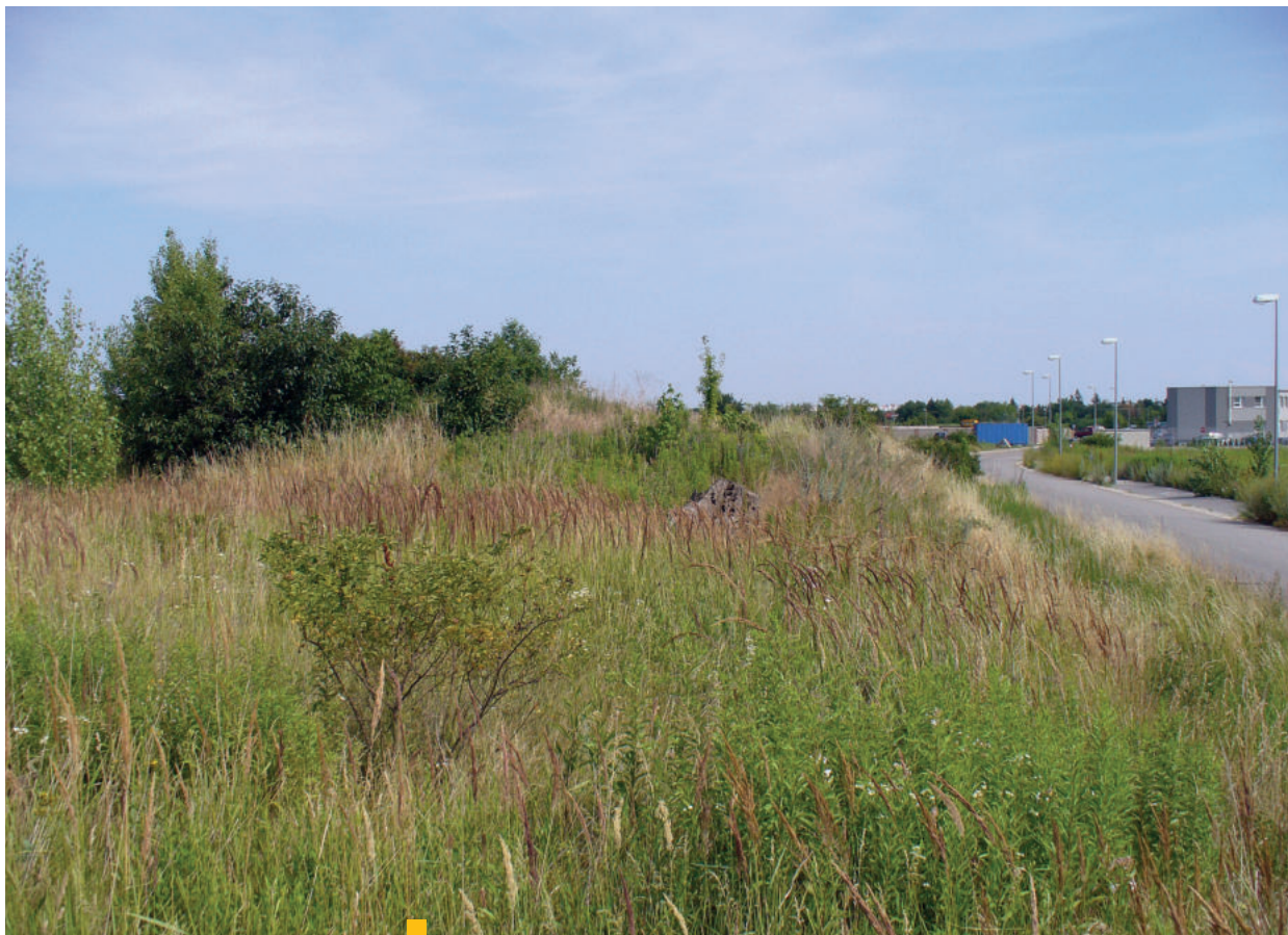
1 b Skládka je situovaná vľavo od cesty
