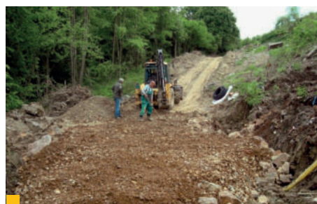
4 Budovanie účelovej cesty
