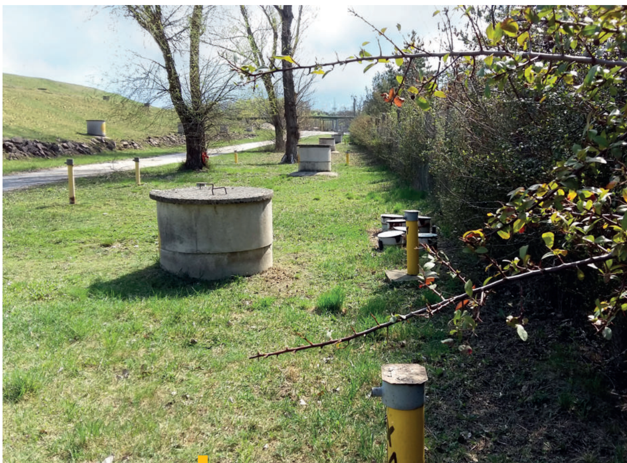
26 Reakčná bariéra v predpolí dočasného odkaliska ENO po dokončení
