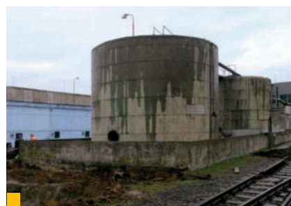
4 Mazutové nádrže počas prvej etapy sanácie
