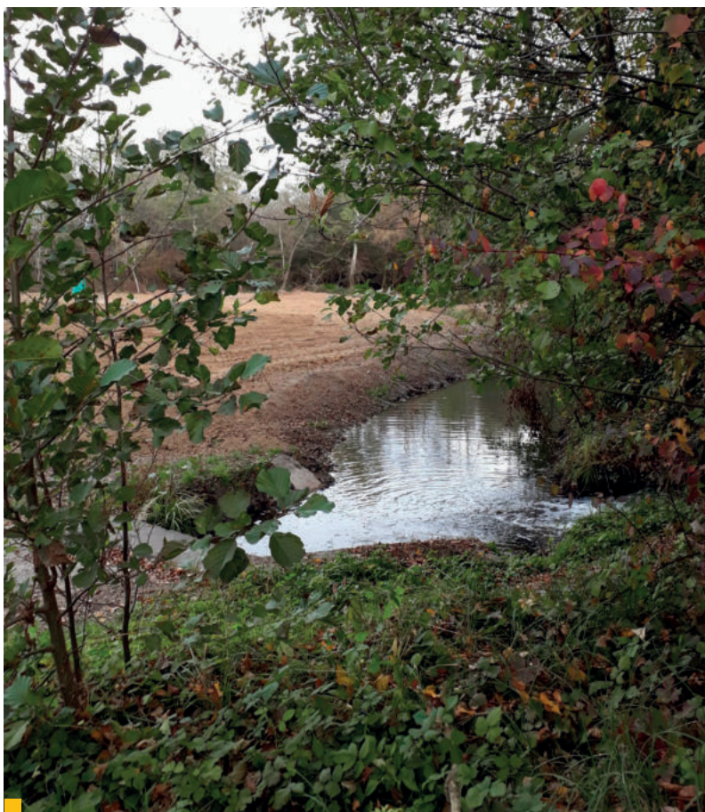
21 Pohľad na lokalitu Zemiansky potok po ukončení sanácie
