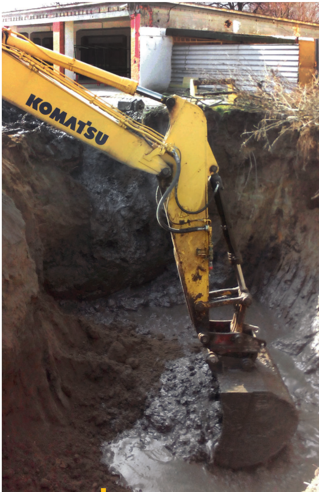
12 Odťahovanie znečistených zemín v oblasti Autopark I
