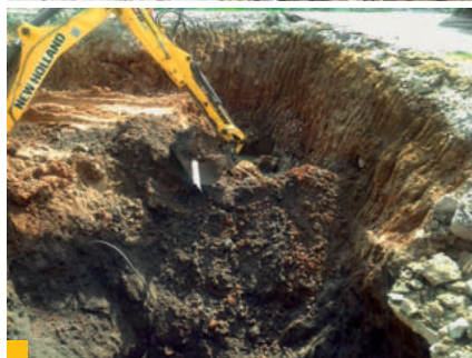
3 | 4 Sanácia zemín ex situ – výkopové práce v čiastkovej lokalite Pekáreň
