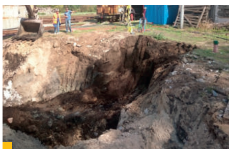
16 Odťahba kontaminovaných zemin. Na zábere sú viditeľné tmavo sfarbené kontaminované zeminy priamo spod zdroja znečistenia lokality – dvoch podzemných nádrží.
