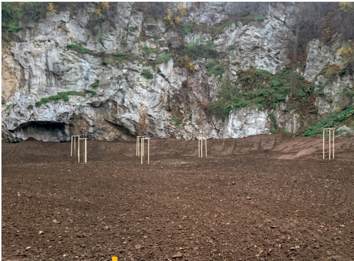
14 Spättný zásyp a rekultivačné práce v kameňolome
