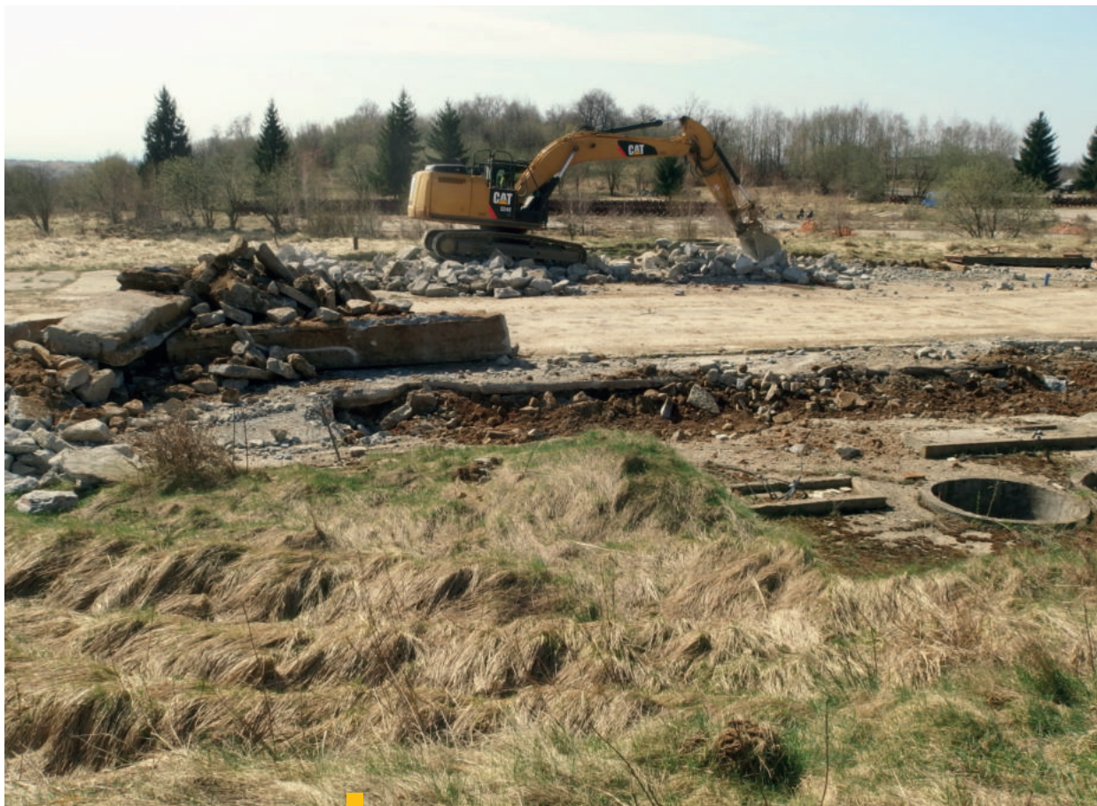
24 Recirkulačná jednotka pred výkopom [15]
