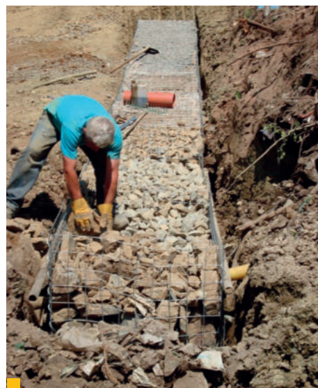
9 Stabilizácia svahu gabiónovým múrom
