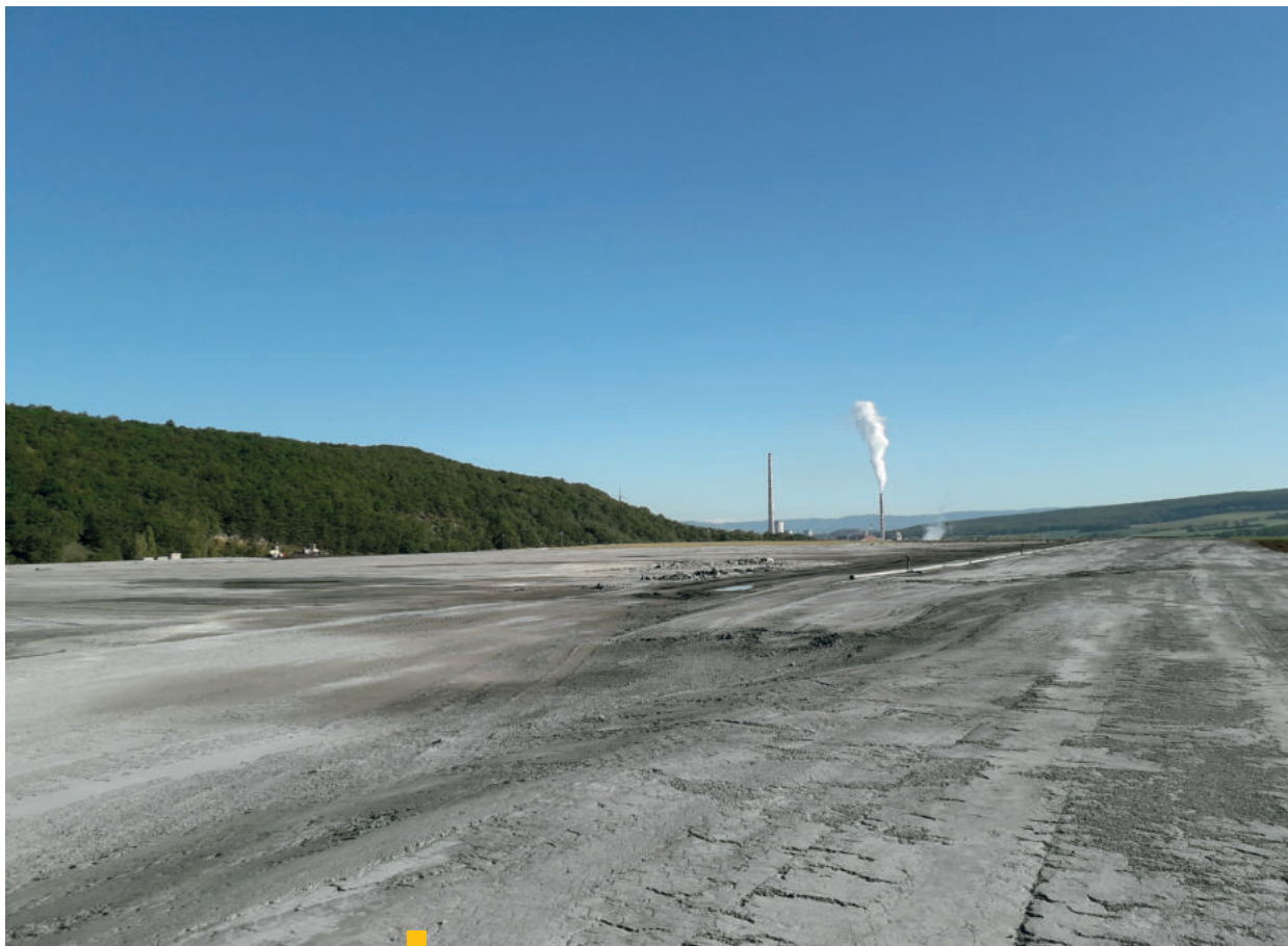
25 Pohľad na dočasné odkalisko Elektrárne Nováky (ENO)
