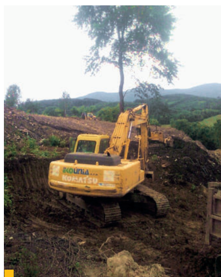
5 Odťažba kontaminovaných zemín
