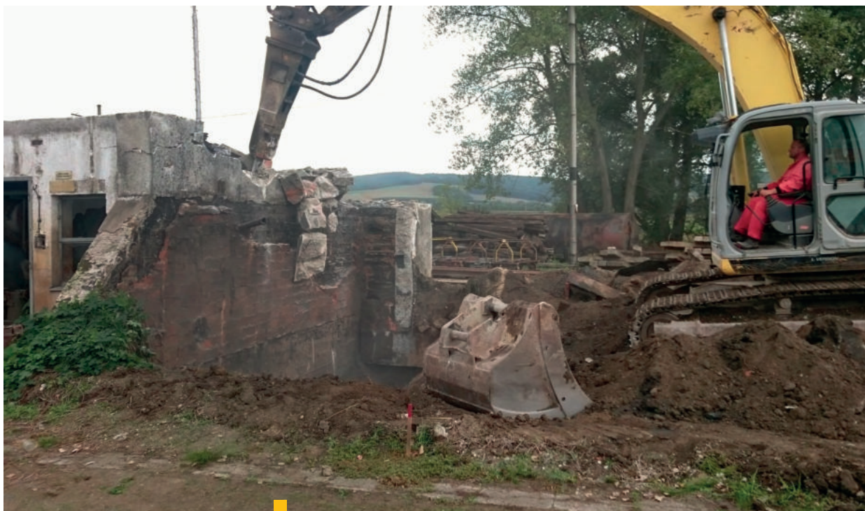
15 Demolácia čerpadlovne
