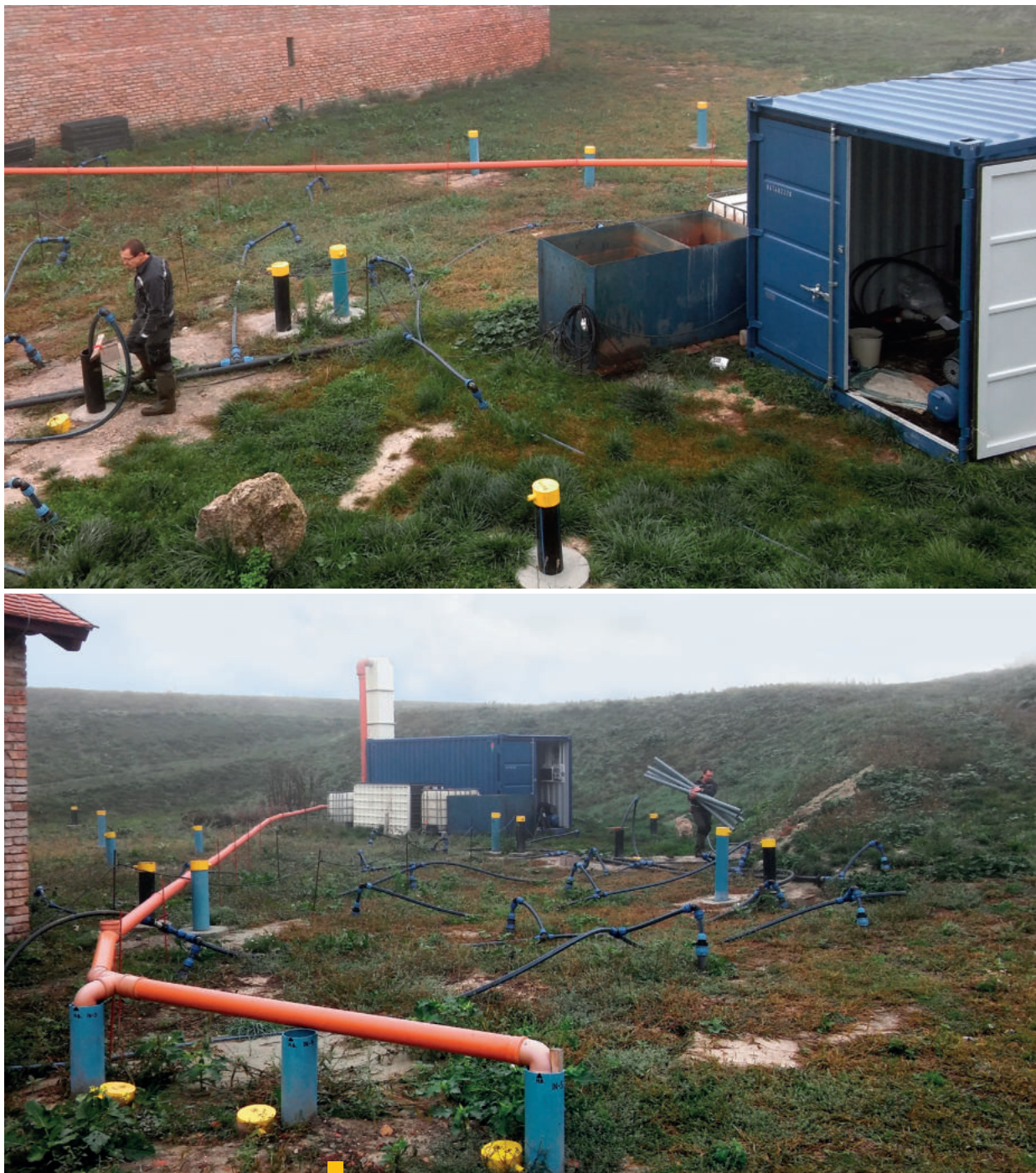
18 | 19 Obr. č. 16, 17, 18 a 19 – sanácia zemin pásma nasýtenia a podzemnej vody metódami in situ
