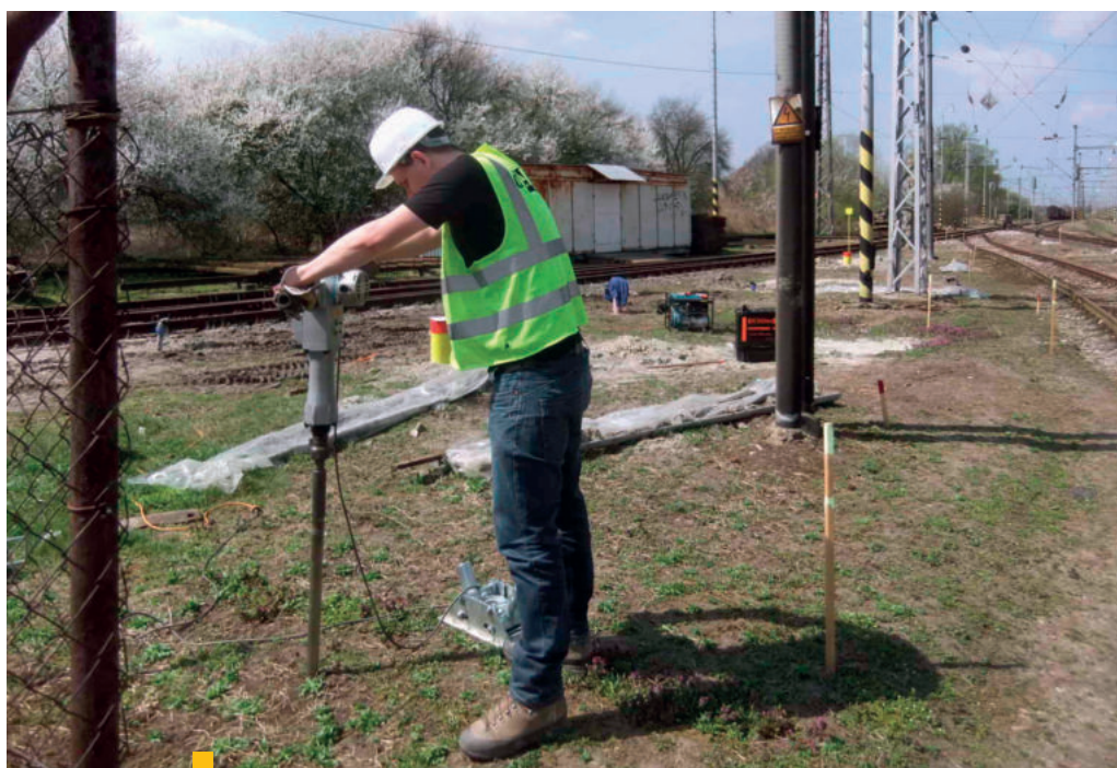
7 Opatrné hĺbenie ventingových vrtov | zdroj: MŽP SR
