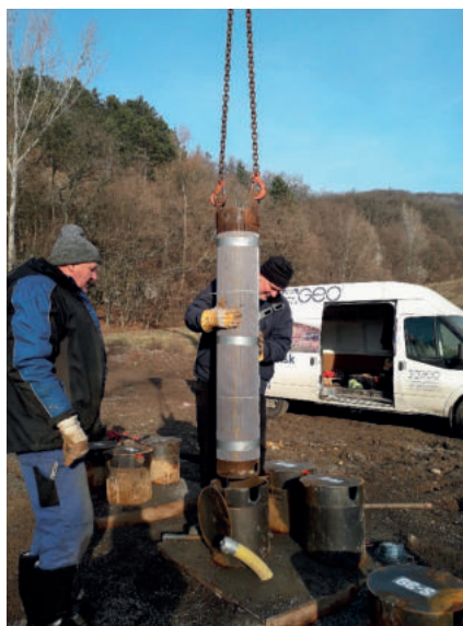
31 | 32 Zabudované reakčné brány a osádzanie reakčných košov
