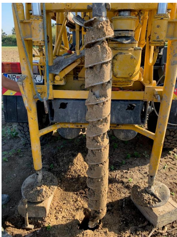
FOTO 7, 8 Vŕtaná sonda VS-4, výnos štrkov, dynamická penetračná sonda PS-4, hĺbka 10,00 m
