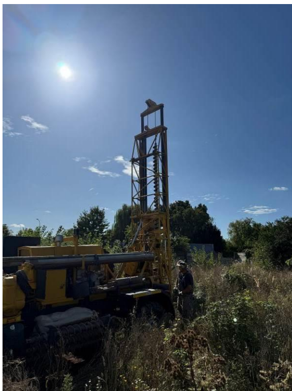
FOTO 9, 10 Vrtaná sonda VS-5, dynamická penetračná sonda PS-5, hĺbka 8,00 m
