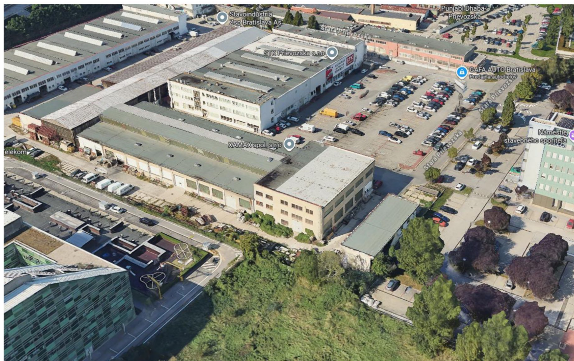
Obr. 7: halové objekty Stavoindustria ZSP Bratislava, na p.č. 115321/1 (zdroj: google.com/maps)
