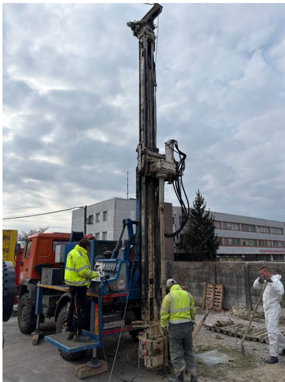
FOTO 5 Vrtaná sonda VS-9, vrtná súprava HVS 455, hĺbka 14,00 m
