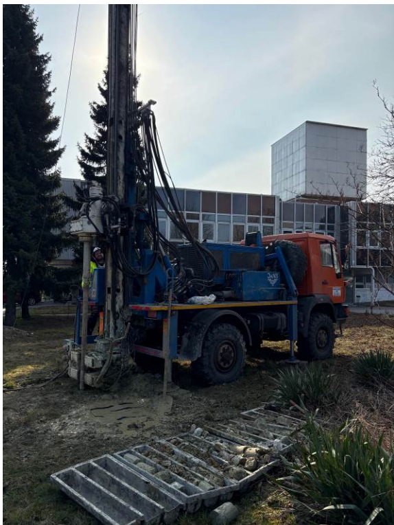
FOTO 1, 2 Vŕtaná sonda VS-1 a VS-7, hĺbka 14,00 m, vrtná súprava HVS 455, jadrovorotačné vŕtanie
