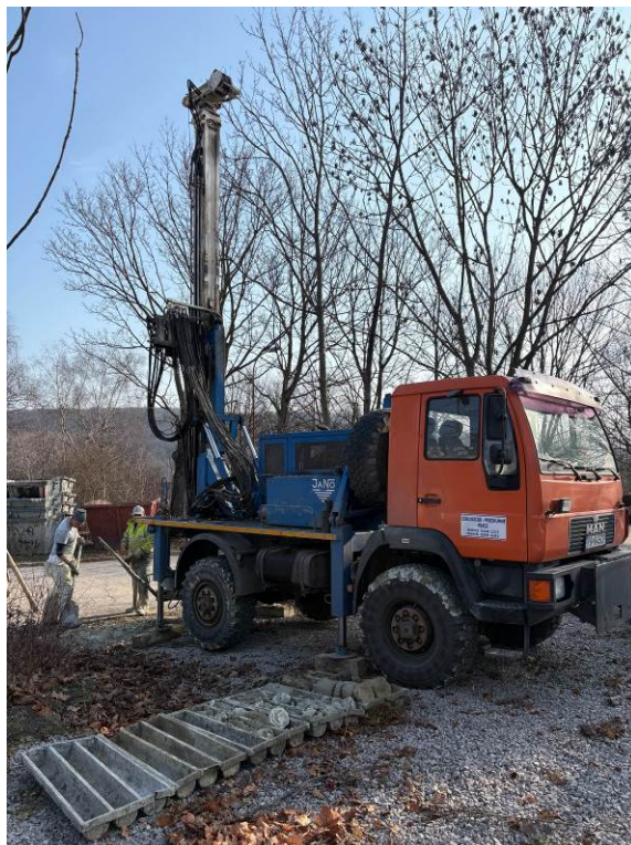
FOTO 1, 2 Vŕtaná sonda VS-1 a VS-7, hĺbka 14,00 m, vrtná súprava HVS 455, jadrovorotačné vŕtanie
