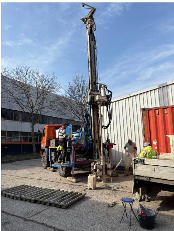
FOTO 3, 4 Vŕtaná sonda VS-8 a VS-10, hĺbka 14,00 m
