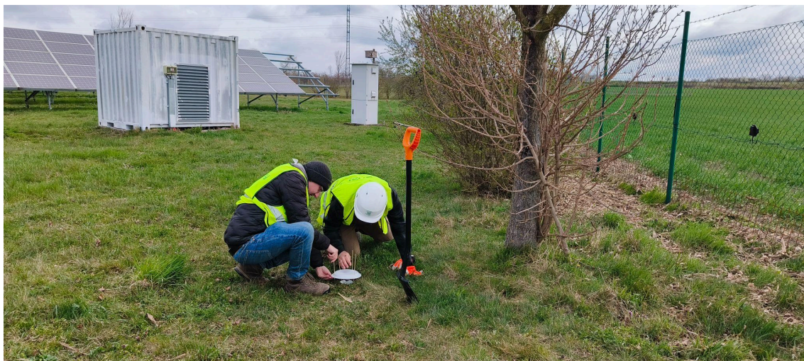
Obr.2. Instalace zemních pastí na FVE Tasov; 7.iv. 2025. Foto: Zdenko Večerík
