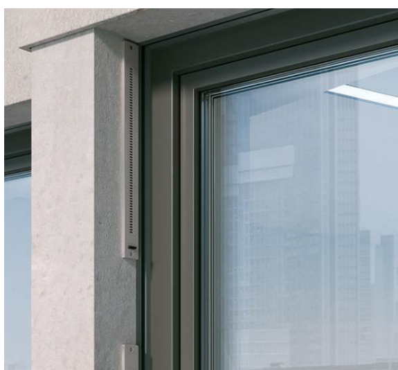
Obr. 45 Příklady aktivních vetracích prvků určených na montáž do obvodového pláště (Siegenia, Systemair, Elektrodesign, Lunos, Dalap, Zender, Schüco, Siegenenia )
