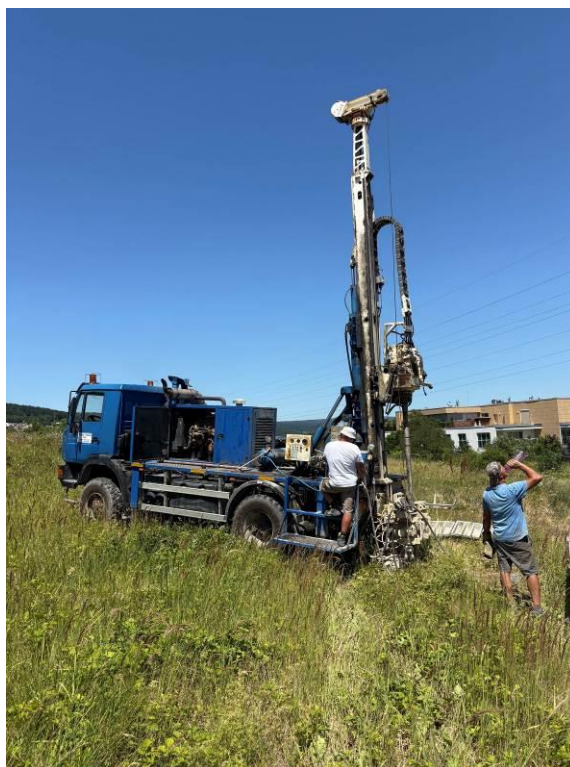
FOTO 1, 2 Vŕtaná sonda VS-1 a VS-3, vrtná súprava HGV 497
