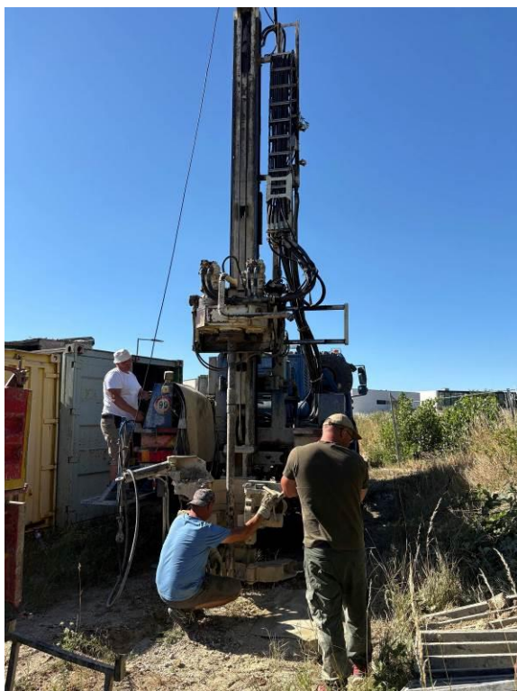
FOTO 1, 2 Vŕtaná sonda VS-1 a VS-3, vrtná súprava HGV 497
