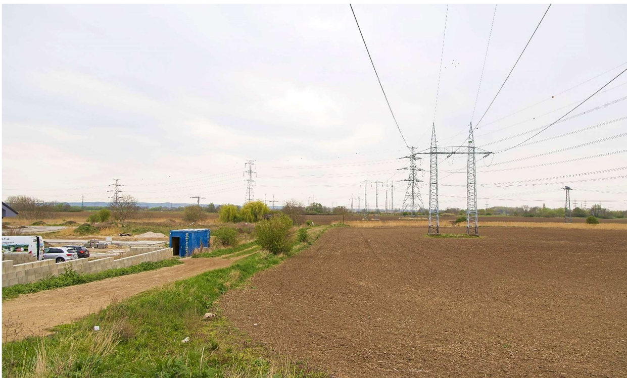
Lokalita ESt Križovany, k.ú. Zavar, 4-2026. Pohľad na úsek vedenia V279 pred elektrickou stanicou s podkrižovaním 400 kV vedení, resp. nadkrižovaním 110 kV vedení. V strede križovanie toku Blava, vľavo južný okraj zastavaného územia obce Zavar.
