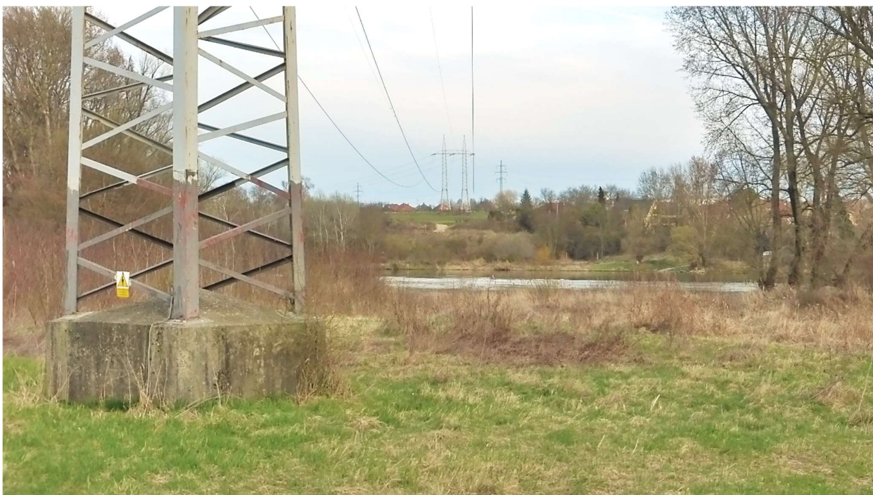
Lokalita Kasárne, k.ú. Sereď, 3-2026. Pohľad v línii vedenia V279 na križovanie Váhu - nadregionálneho biokoridoru (v strede). Na opačnom brehu obec Šintava - rohový stožiar umiestnený v blízkosti severného okraja zastavaného územia obce.
