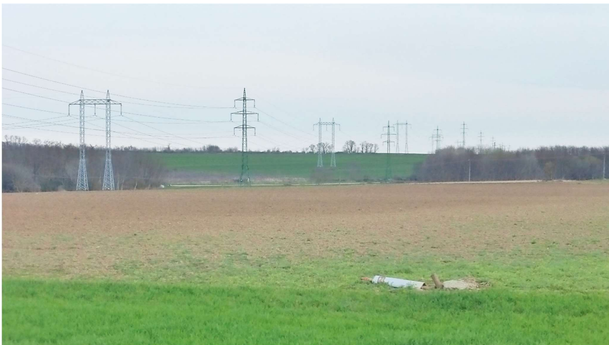
Lokalita Kráľova hora, k.ú. Šintava, 3-2026. Koridor vedenia V279 a súbežného 2x110 kV vedenia križuje potok Hlohovský a za ním okraj vinogradov.
