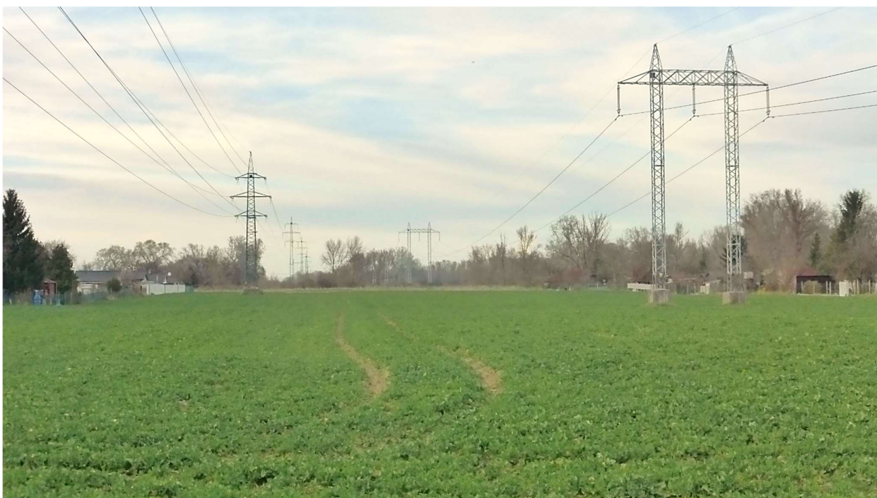
Lokalita Záhradkárska oblasť, k.ú. Sered', 3-2026. Trasovanie vedenia V279 v inundačnom území Váhu vo voľnom koridore ornej pôdy. Vľavo súbežné vedenie 2x110 kV. Po oboch stranách popri spoločnom koridore vedení sa nachádzajú záhrady miestnej záhradkárskej oblasti.
