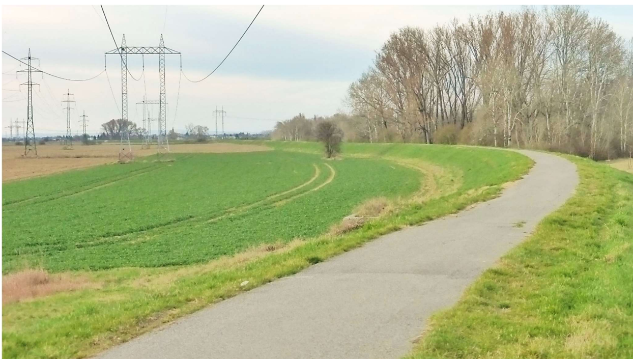
Lokalita Stredný Čepeň, k.ú. Sered', Stredný Čepeň, 3-2026. Pohľad v línii vedenia V279 v smere späť do ESt Križovany z pravostrannej hrádze Váhu. Vľavo súbežné 2x110 kV vedenie, vpravo topoľové porasty v inundácii Váhu, v pozadí 400 kV vedenie V425 odchádzajúce od spoločného koridoru s V279 (začiatok línie alternatívneho trasovania inovovaného vedenia - lokálnej obchádzky Serede).
