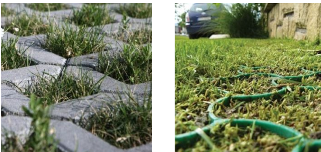
Obr. 13 – Príklad zatravnňovacie rohože alebo zatravnňovacie tvárnice.
