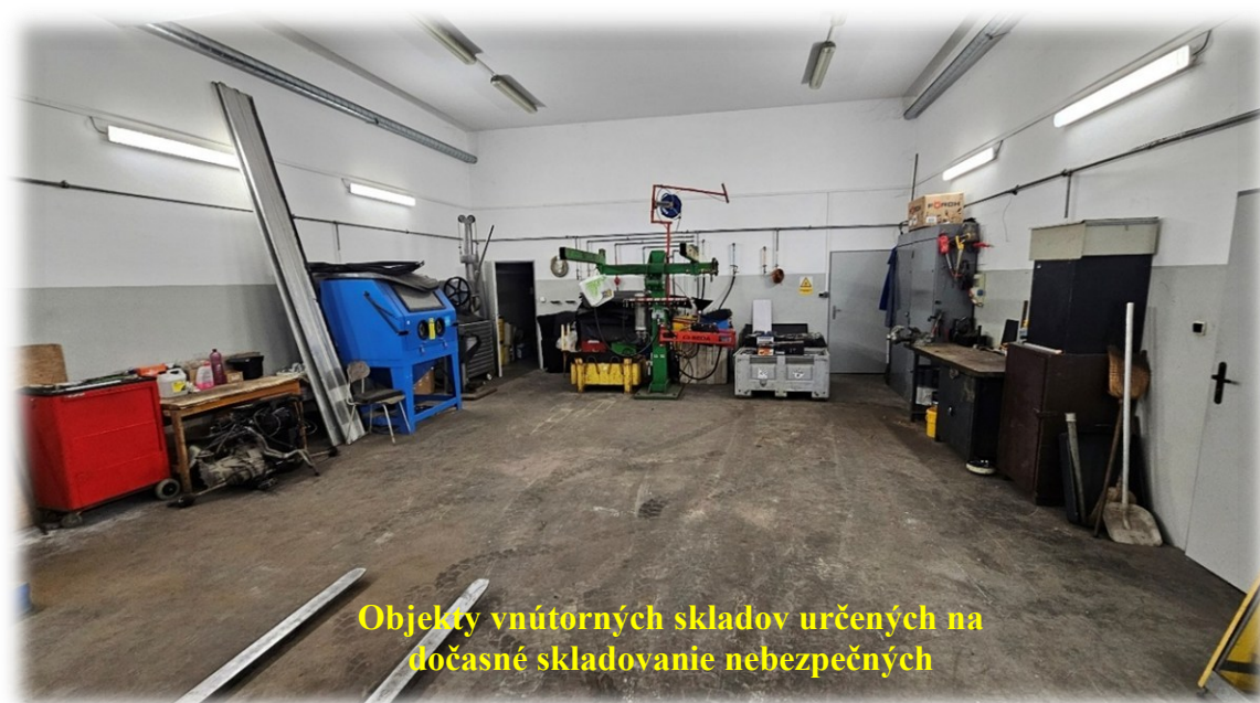
Objekty vnútorných skladov určených na dočasné skladovanie ostatných odpadov
