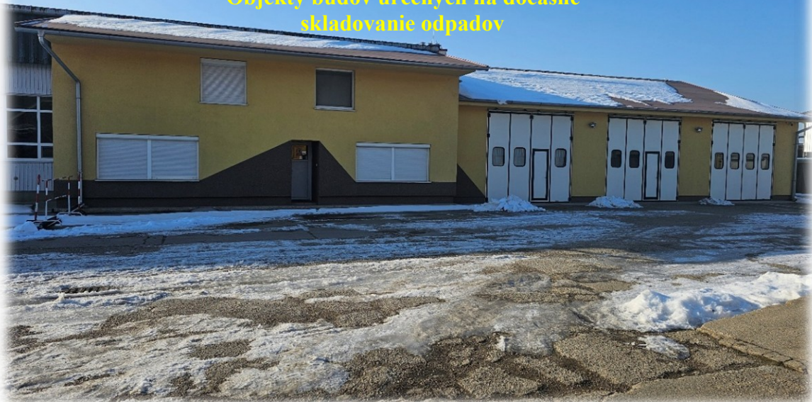
Objekty budov určených na dočasné skladovanie odpadov
