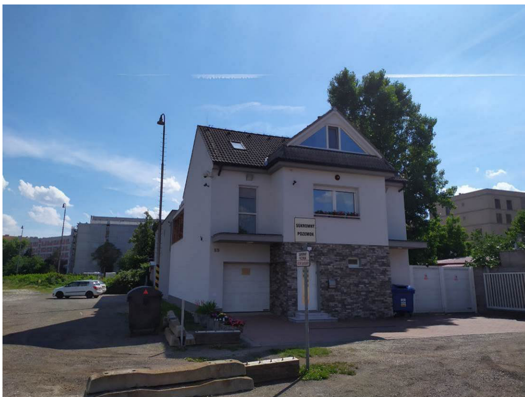
Obr. 29 miesto hodnotenia MH 8 pred fasádou rodinného domu na Kominárskej 13 v Bratislave
