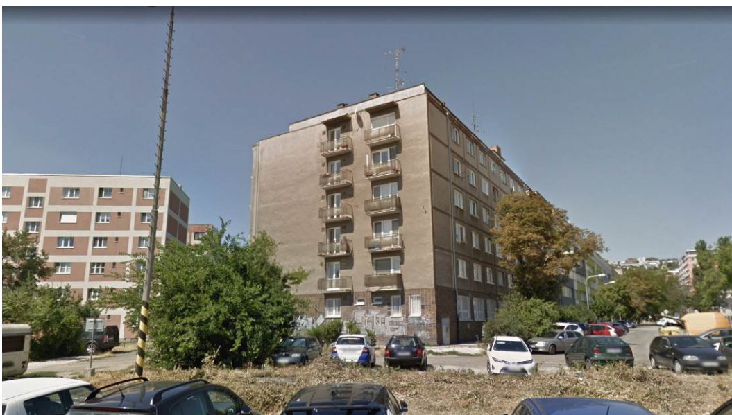
Obr. 31 miesto hodnotenia MH 10 v mieste bytov pred fasádou bytového domu na Kominárskej 6 v Bratislave ( podklad : www.google.com/maps )
