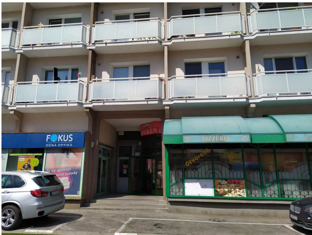
Obr. 26 miesto hodnotenia MH 5 v mieste bytov pred fasádou polyfunkčného domu na Škultétyho 10 v Bratislave
