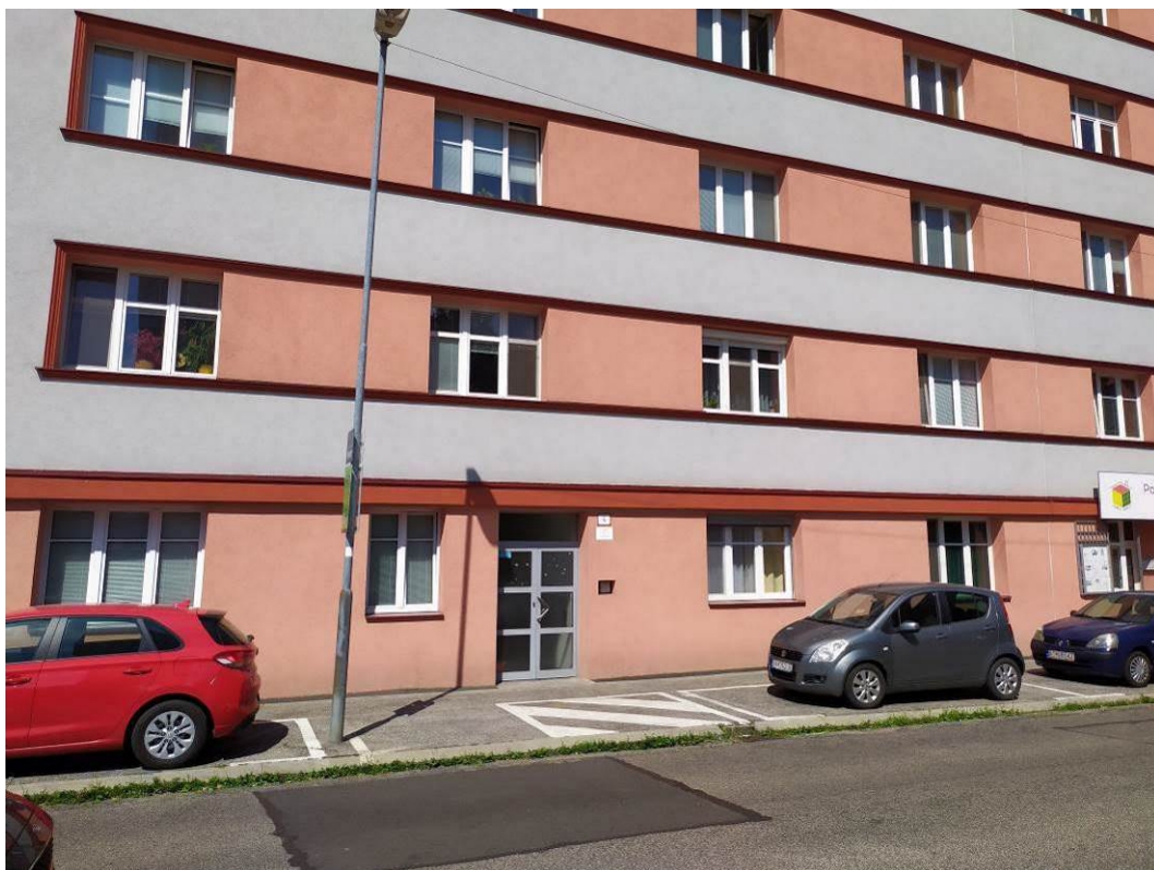
Obr. 25 miesto hodnotenia MH 4 v mieste bytov pred fasádou polyfunkčného domu na Škultétyho 4 v Bratislave
