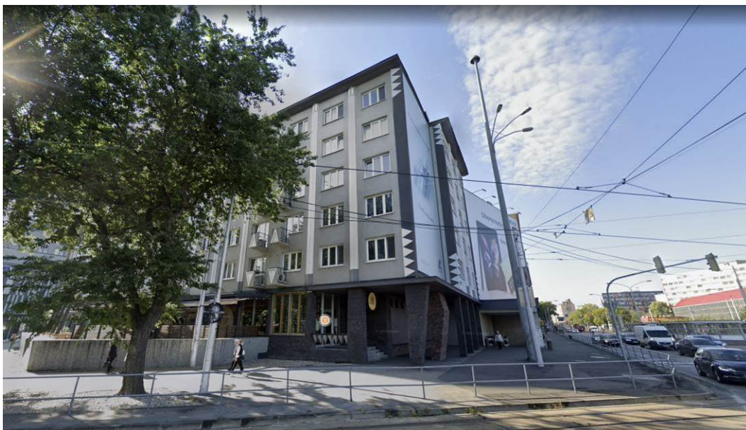
Obr. 22 miesto hodnotenia MH 1 v mieste bytov pred fasádou polyfunkčného domu na Krížnej 64 v Bratislave ( podklad : www.google.com/maps )
