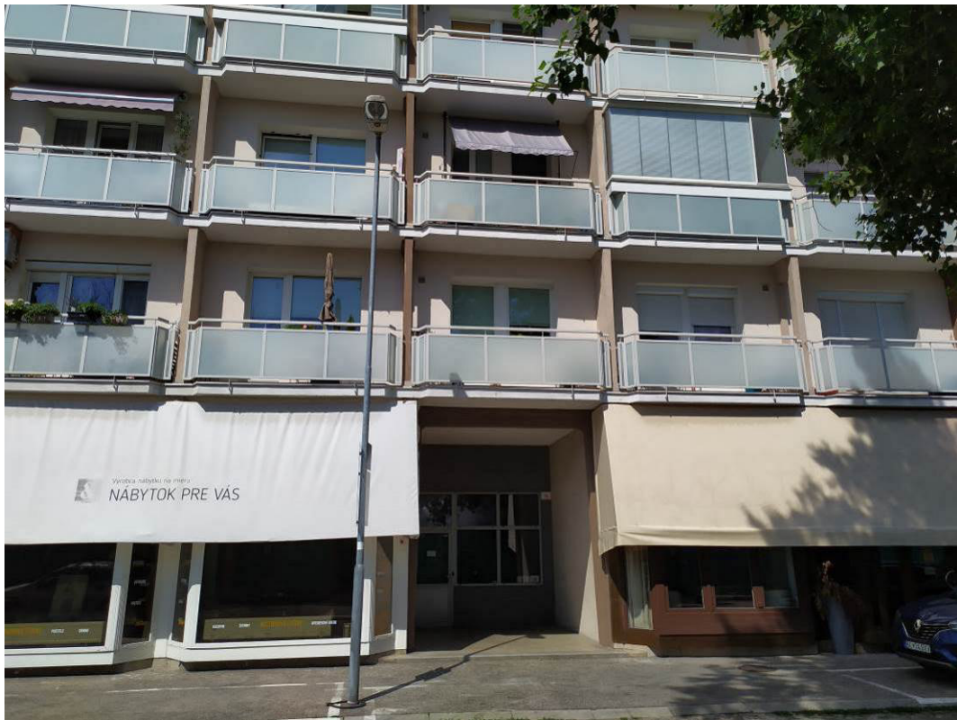
Obr. 27 miesto hodnotenia MH 6 v mieste bytov pred fasádou polyfunkčného domu na Škultétyho 16 v Bratislave
