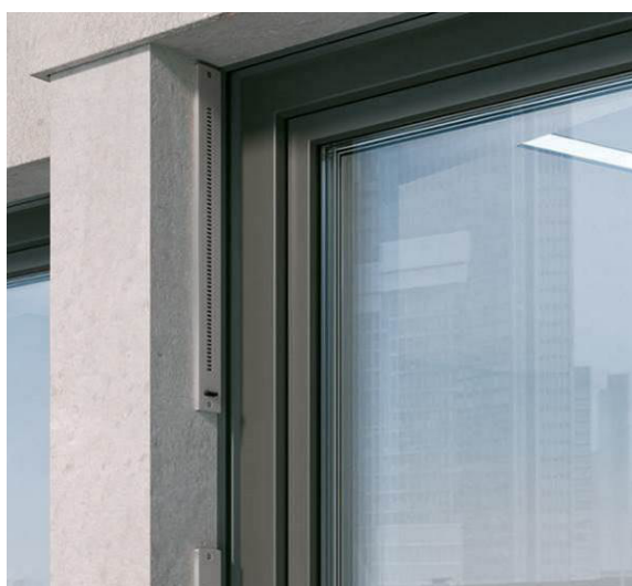
Obr. 37 příklady aktivních vetracích prvků určených na montáž do obvodového pláště (Siegenia, Systemair, Elektrodesign, Lunos, Dalap, Zender, Schüco, Siegenenia )
