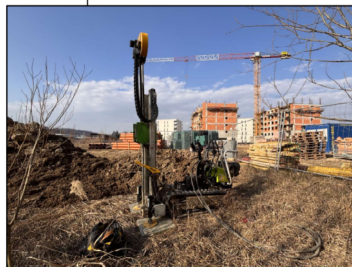
Foto 01: Dynamická penetračná sonda DP-2
