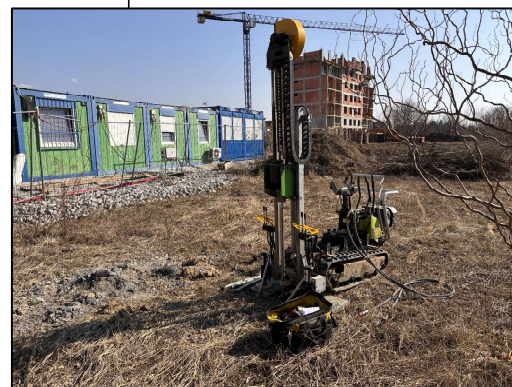
Foto 01: Dynamická penetračná sonda DP-1
