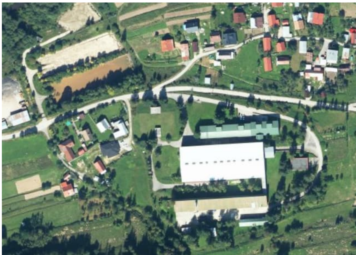
Obr.č.1 Úpravňa vody a kalové lagúny.
