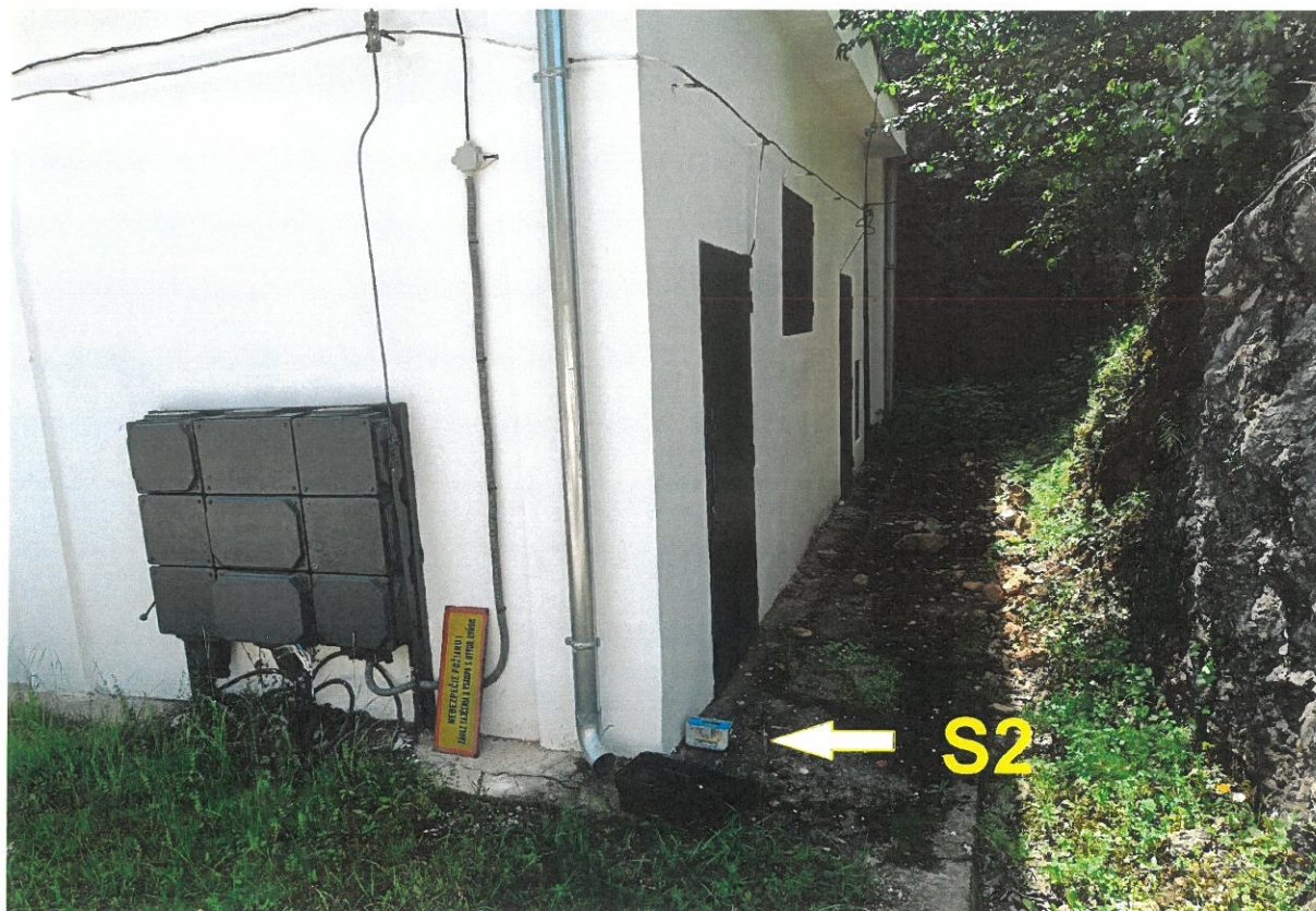
Obr. 4 Meracie stanovisko S2 - sklad trhavín, situovanie meracej aparatúry ABEM Vibratloc na betónovom základe objektu.
