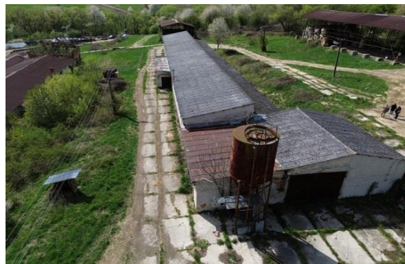
Pohľad na ten istý objekt* – azbestová krytina
