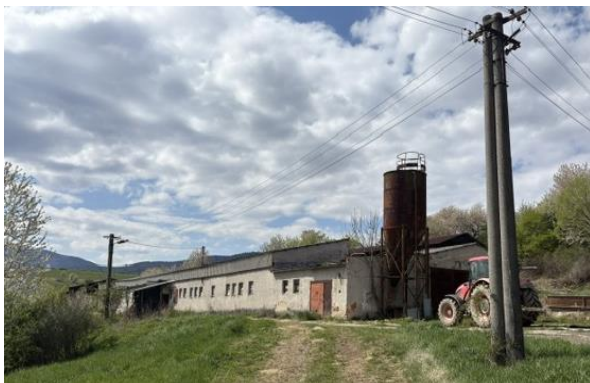
Pohľad na asanovaný objekt (bývalý ovčín)
