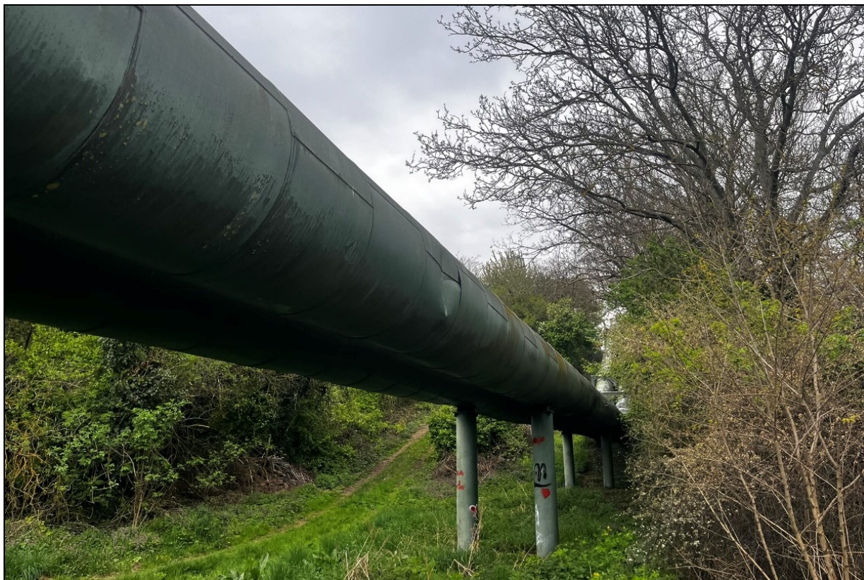
Obrázok č. 10 Vedenie parovodu na hranici južnej strany lokality
