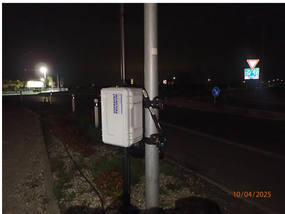
Foto 2 – Zariadenie ASD 640 – km 37,193 c.I/63 pohľad smer BA
