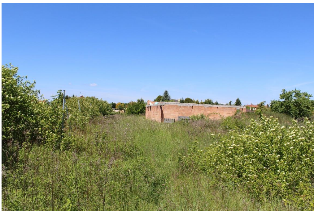
Obr. 6 Centrálna časť dotknutých pozemkov a rozostavané objekty rodinných domov
