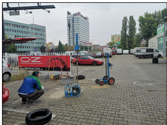
Obr.3: Realizácia dynamickej penetračnej skúšky – sonda DPS-2 – pohľad južným smerom
