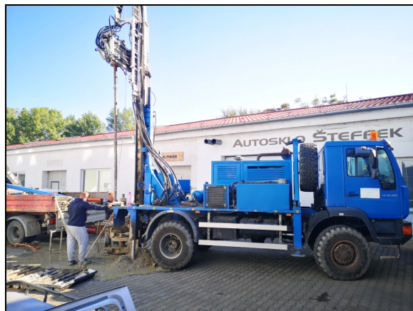
Obr.2: Realizácia vrtných prác – vrt S-5
