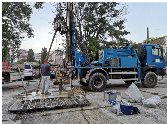
Obr.1: Realizácia vrtných prác – vrt S-1 - pohľad severným smerom
