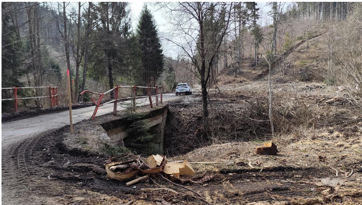
Obrázok 17: Cestný premostenie Podtajchovského potoka v mieste jeho vtoku do Vydrovského potoka
