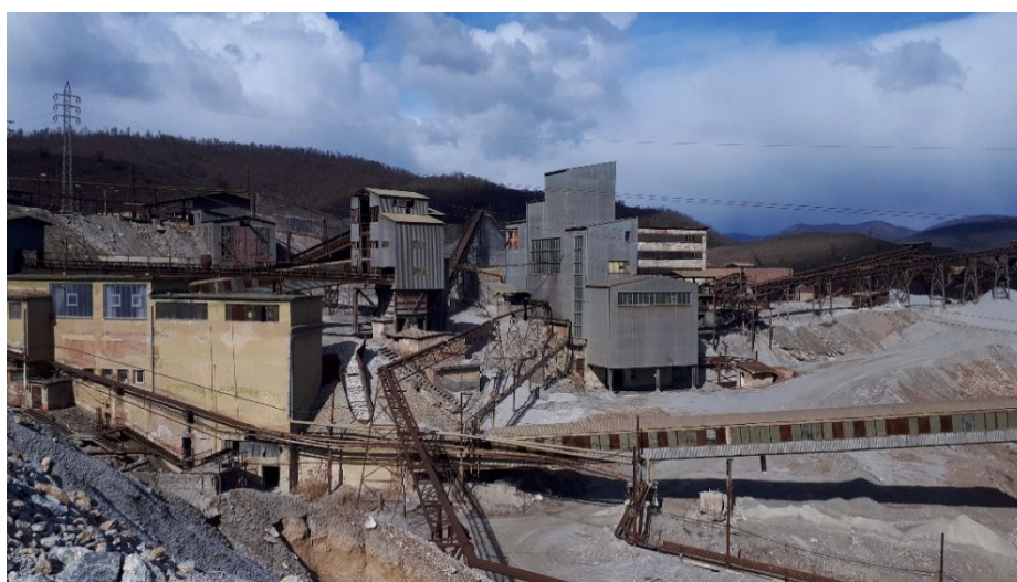
Foto č. 7: Povrchová prevádzka
