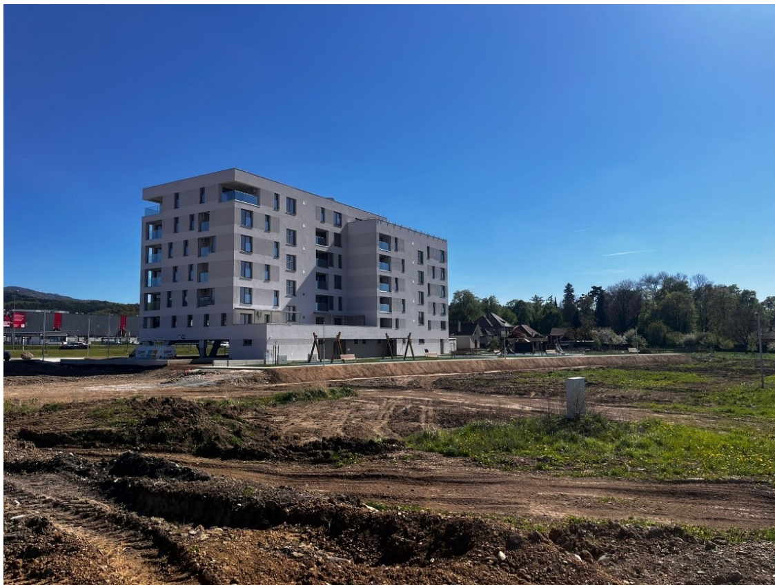
Obrázok č. 4 - Časť objektovej sústavy vo výstavbe – bytový dom SO 01
