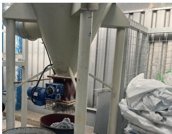
FOT. 4 Pohľad na čerpadlo
