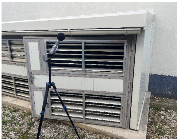
FOT. 11 Pohľad na čerpadlo
