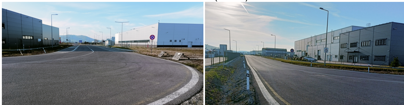
Obr. 12: Pohľad na prístupové komunikácie v mieste budúceho kruhového objazdu (smerom na SZ k ceste I/61 a JZ k ceste III/1091 (03/2026).
