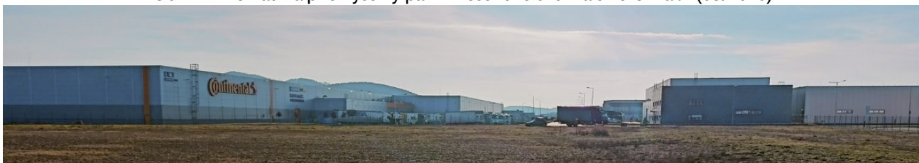
Obr. 11: Pohľad na priemyselný park z riešeného územia smerom a JZ (03/2026).
