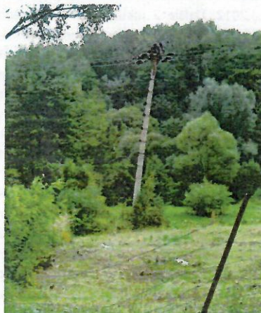
Foto 3: Naklonenie stĺpa elektrického vedenia v areáli skládky NNO
