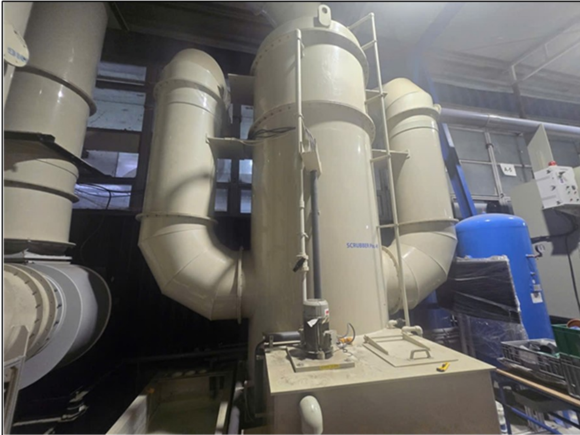
Obrázok č. 5 - Veža na čistenie odpadových plynov z neutralizačnej stanice
