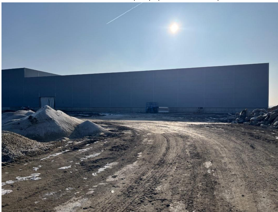
Obrázok 3 Rozostavaná stavba haly - pohľad zo severu
