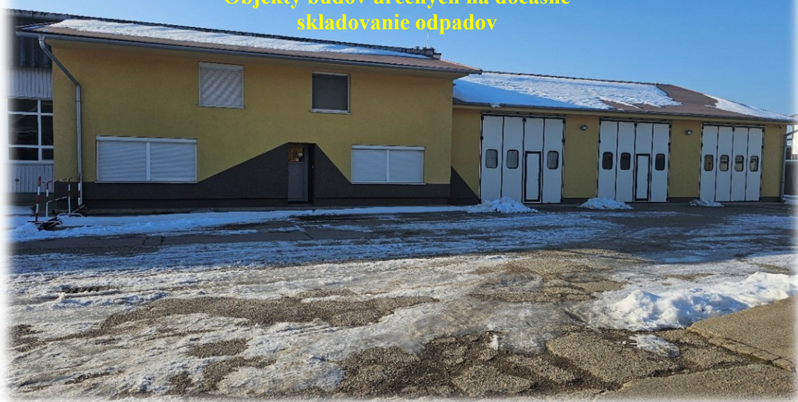
Objekty budov určených na dočasné skladovanie odpadov
