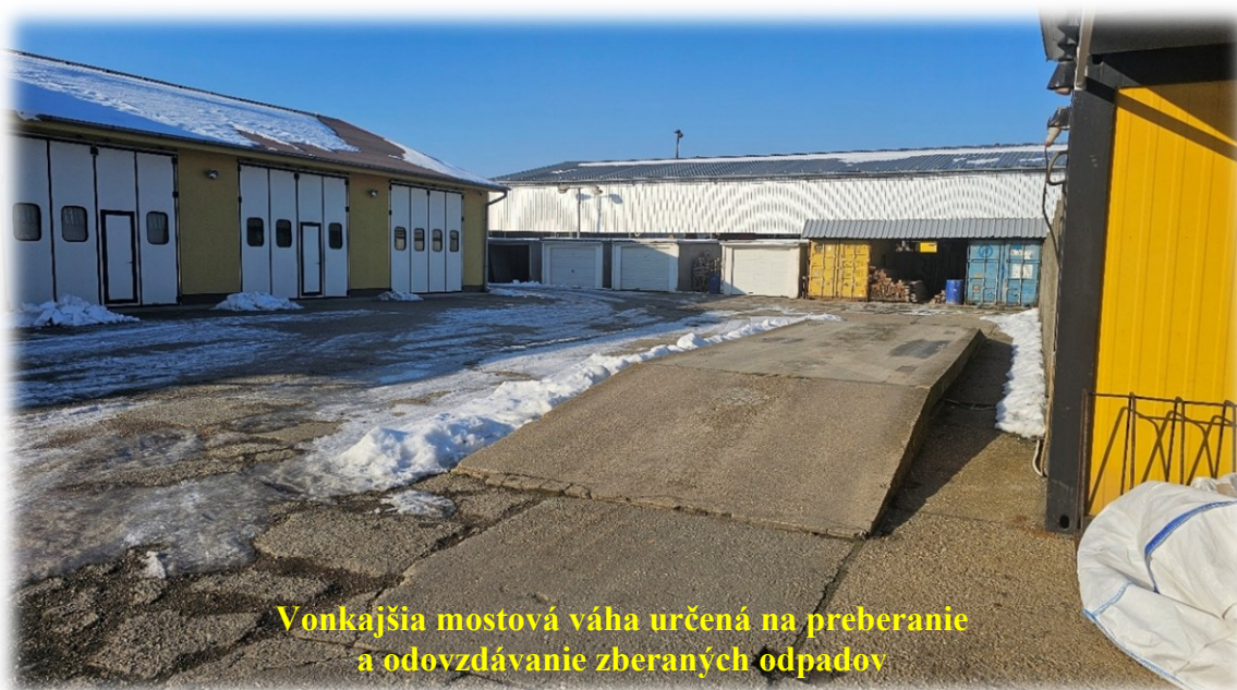
Vonkajšia váha určená na preberanie odpadov
