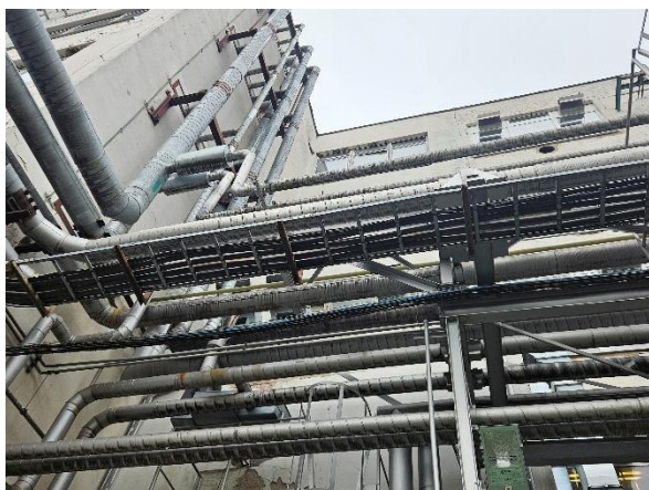
FOT. 3 Výduchy vzduchu na fasáde
