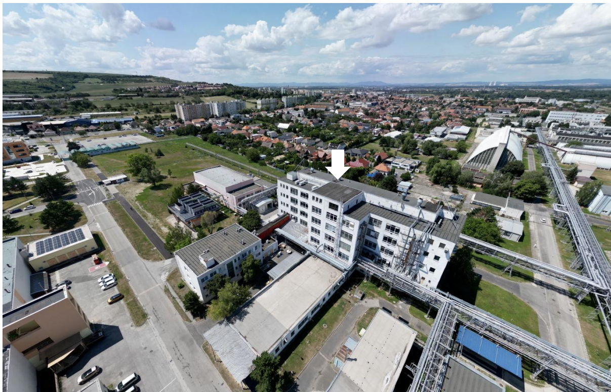
OBR. 4 Pohľad na objekt č. 45 „Unihala“ zo severojužnej strany (zdroj: Google Maps)
