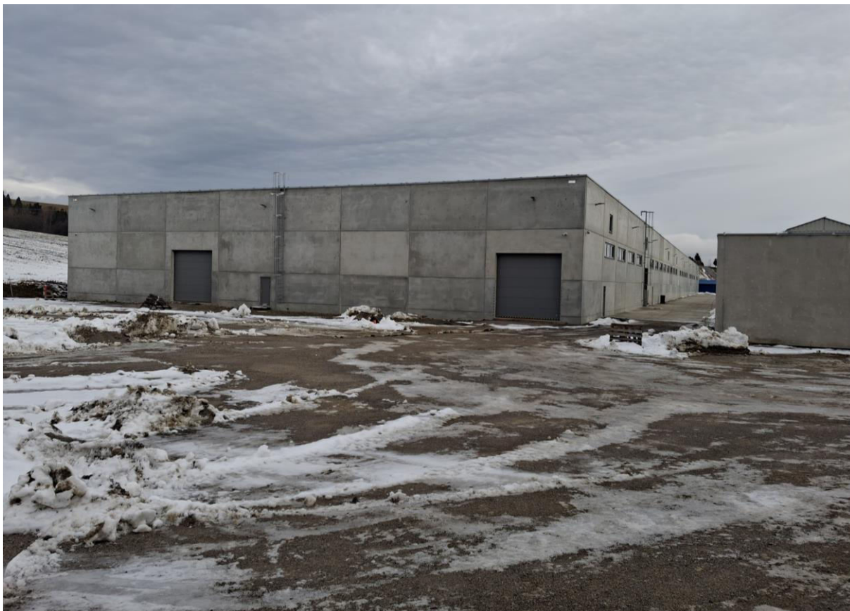
Foto 1 Miesto prístavby skladovacej haly k novej výrobnej hale
