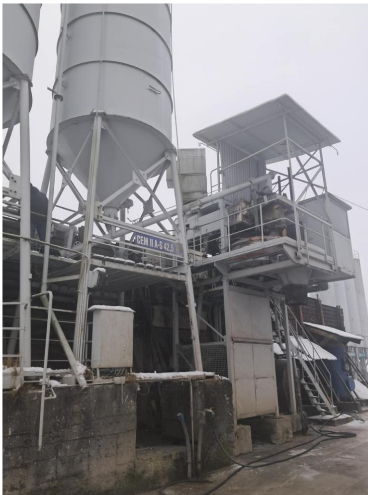
Foto č. 2 Pohľad na existujúcu technológiu betonárne
