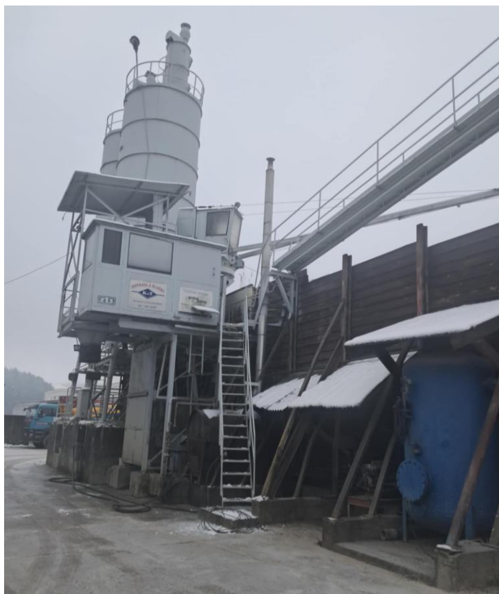
Foto č. 1 Betonáreň s typovým označením SB-20 , súčasný stav
