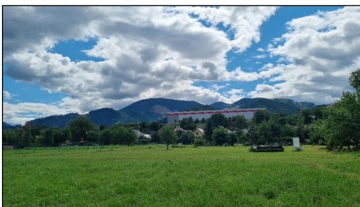
Objekty priemyselného parku na vyvýšenej polohe terasy nad zástavbou na ulici Kamenná v mieste vstupu do lokality
