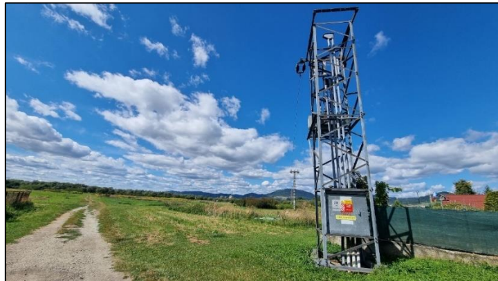
Pohľad na lokalitu z východu od rodinných domov na ulici Za Záhradami, v popredí trafostanica a elektrické vedenie, ktoré budú demontované
