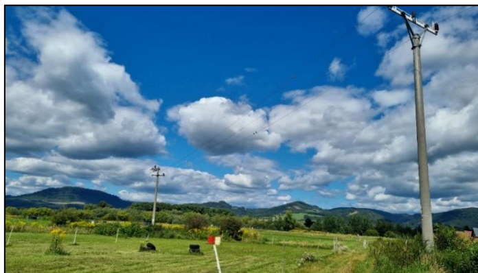
Neúžitky (aj so zlatobyľou) pod stĺpmi VN vedenia
