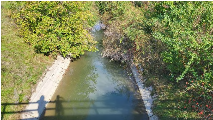
Obr. č. 2: kanál Malinovo-Blahová v Tomášove, 09/2025
