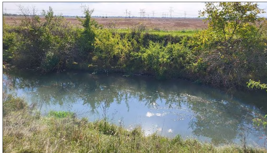
Obr. č. 3: kanál Malinovo-Blahová, Malinovo Patov, 09/2025
