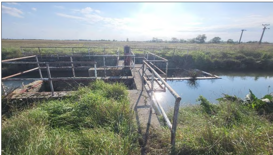
Obr. č. 9: kanál Tomášov – Lehnice, stavidlo Štvrtok na Ostrove, 09/2025
