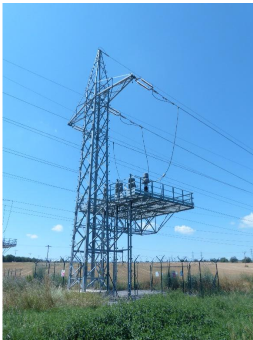
Obr. Príklad prechodu medzi vzdušným a káblovým vedením
