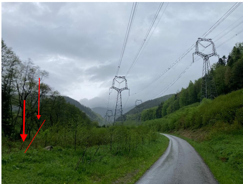
Obr. Prvá polovica Hiadeľskej doliny, umiestnenie nového vzdušného vedenia v súbehu s existujúcimi 400 kV vedeniami na ľavej strane
