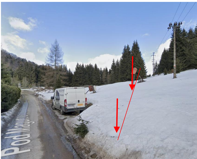
Obr. Umiestnenie vedenia v lokalite Pod Magurkou
