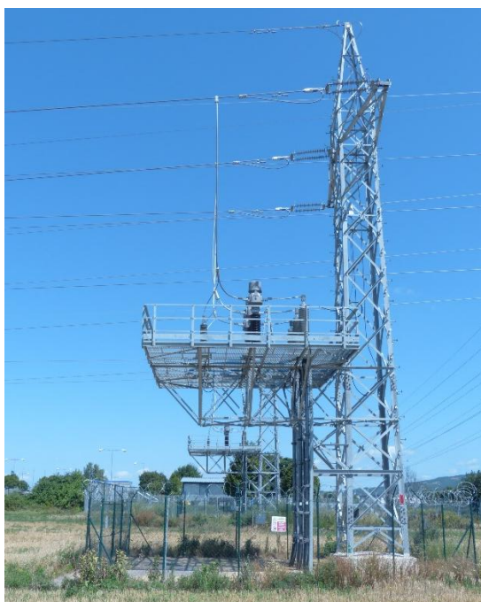
Obr. Príklad prechodu medzi vzdušným a káblovým vedením
