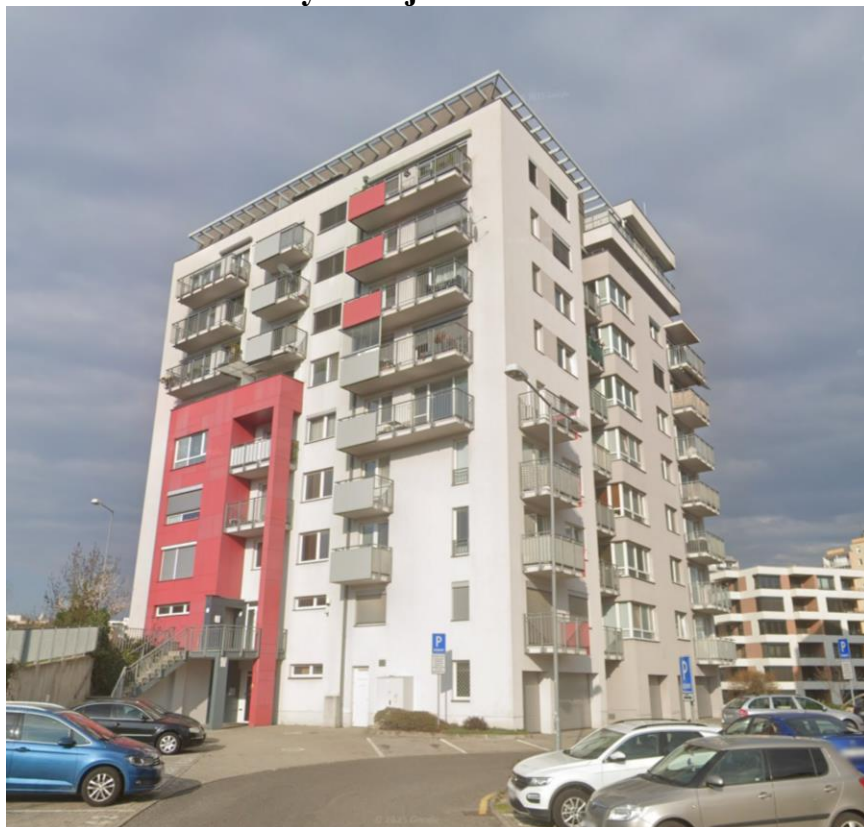
Obr. 14: Existujúuci objekt: BD Kadnárova 99 (zdroj: google.com)
