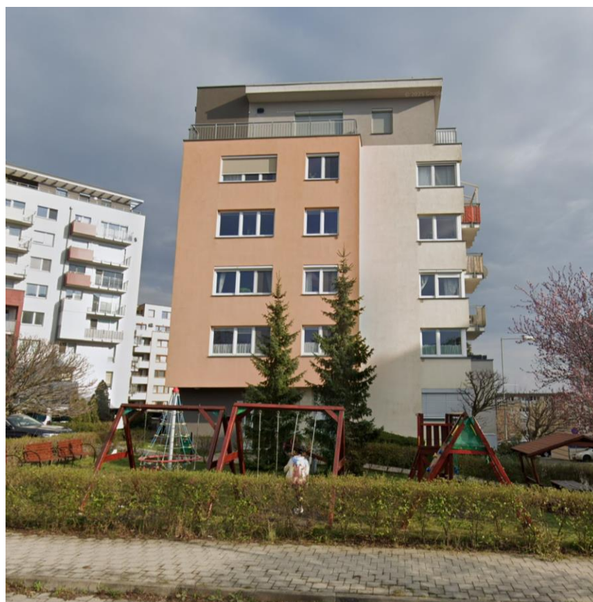
Obr. 15: Existujúuci objekt: BD Kadnárova 97 (zdroj: google.com)
