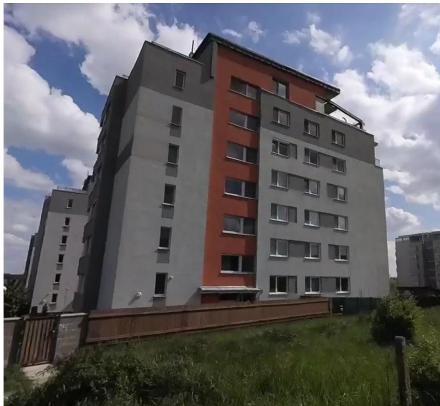
Obr. 16: Existujúuci objekt: BD Kadnárova 89 (zdroj: google.com)
