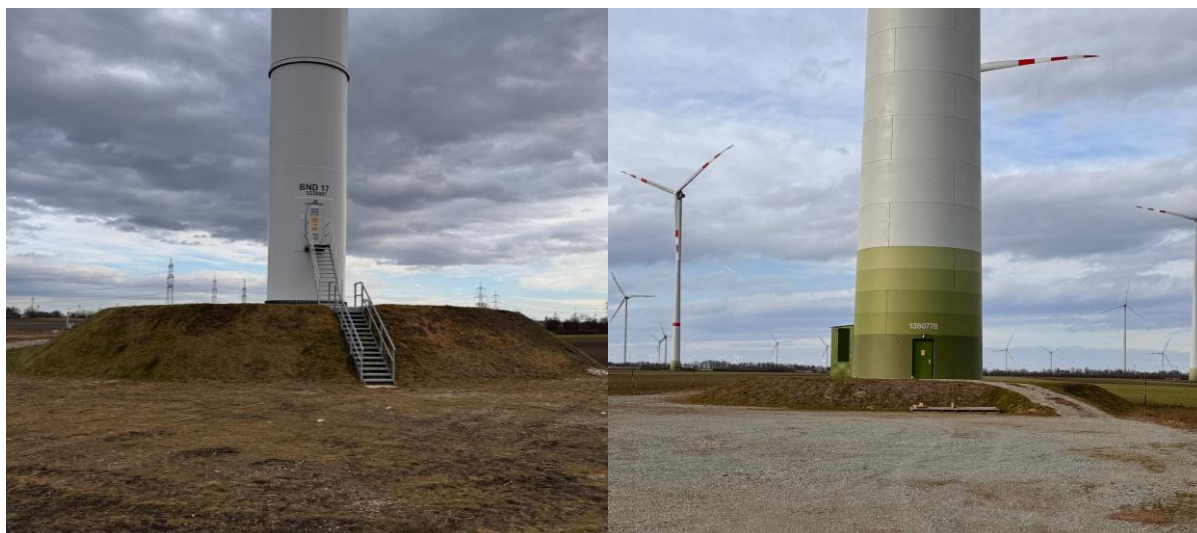
Obr. č. 3: Fotografické príklady zapustenia základu veternej elektrárne
