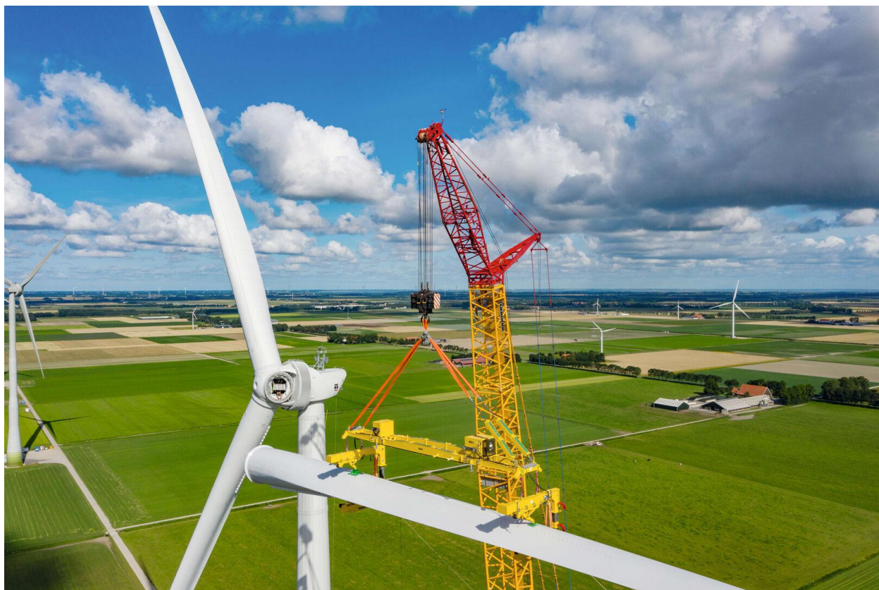
Obr. č. 6: Záber z montáže rotora veternej elektrárne
