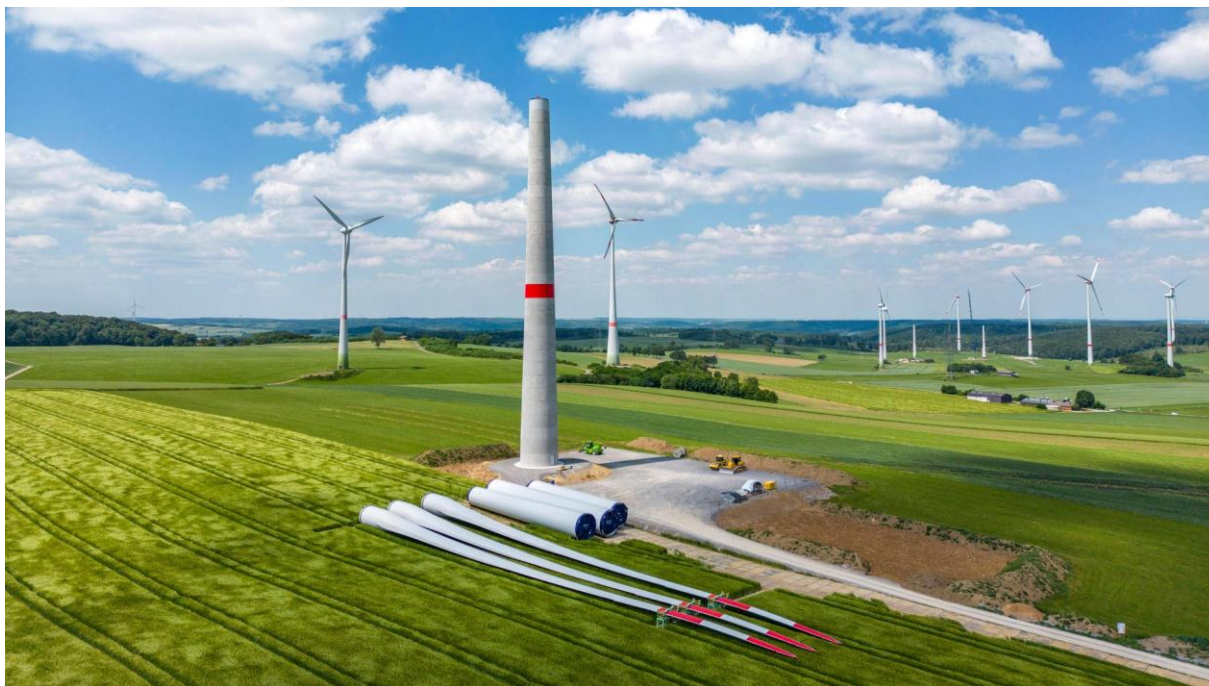
Obr. č. 1: Manipulačná plocha - veterná elektrárň počas výstavby
