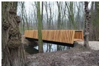
Lávka cez potok Biela voda
