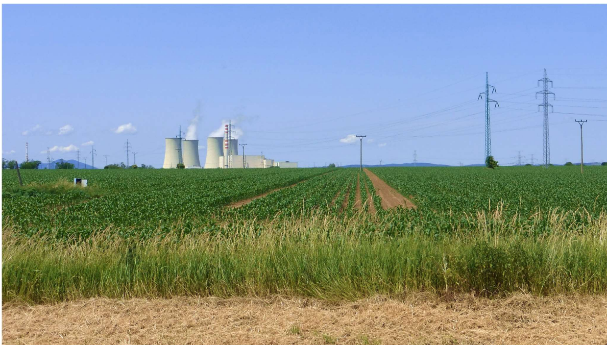
Lokalita Hektáre, k.ú. Pečeňady, 6-2025. Pohľad na koridor súčasných vedení v smere do areálu jadrových elektrární (v pozadí) z cesty II/504. Zľava prvé jednoduché 110 kV vedenie V8312 bude demontované a zdvojené (A9 - SO 01.7), druhé dvojité 2x110 kV vedenie V8314/8849 bude využité pre trasovanie nového vedenia 2x110 kV V8312a/8849a (A9 - SO 01.6). Koridor bude rozšírený z pravej strany o dve nové vedenia: 2x110 kV V8314/8849 (A9 - SO 01.5) a 1x110 kV RNVS-Z (A7a - SO 01).
