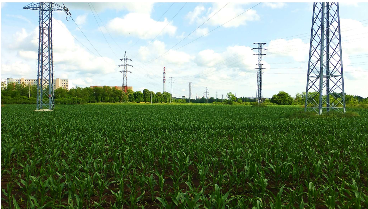
Lokalita Za hradbami, k.ú. Trnava, 6-2025. Pohľad z okraja staveniska (Bytové domy Kamenný mlyn) na spoločný koridor vedení 2x110 kV (ľavé) a dvoch 2x22 kV v smere do ESt Trnava - centrum. Koridor vedie po ornej pôde, kde križuje železničnú trať č.116 (v strede). Vľavo okraj sídliskovej zástavby Prednádražie. Nové 2x110 kV vedenie 8831/8896 (A9 - SO 01.1) bude vedené paralelne s existujúcim 2x110 kV vedením - v línii namiesto 2x22 kV vedení, ktoré budú kabelizované.
