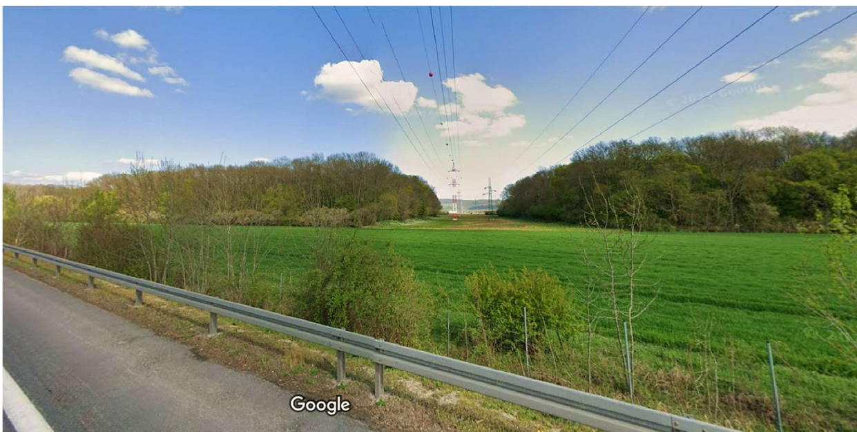
Lokalita Pod hájom, k.ú. Veľké Kostolany, 6-2025. Pohľad z diaľnice D1 na koridor existujúcich vedení s priesekom cez lesný areál lužného lesa (významný biotop). Sprava prvé jednoduché 110 kV vedenie V8312 bude zdvojené (A9 - SO 01.7), druhé dvojité 2x110 kV vedenie V8314/8849 bude využité pre trasovanie nového vedenia 2x110 kV V8312a/8849a (A9 - SO 01.6). Koridor bude rozšírený z ľavej strany o dve nové vedenia: 2x110 kV V8314/8849 (A9 - SO 01.5) a 1x110 kV RNVS-Z (A7a - SO 01), s rozširujúcim výrubom v prieseku. Zdroj: www.google.com/maps
