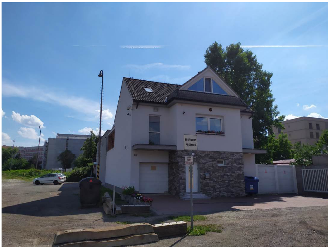
Obr. 25 výpočtový bod VB 8 vo výške 5 m pred fasádou rodinného domu na Kominárskej 13 v Bratislave
