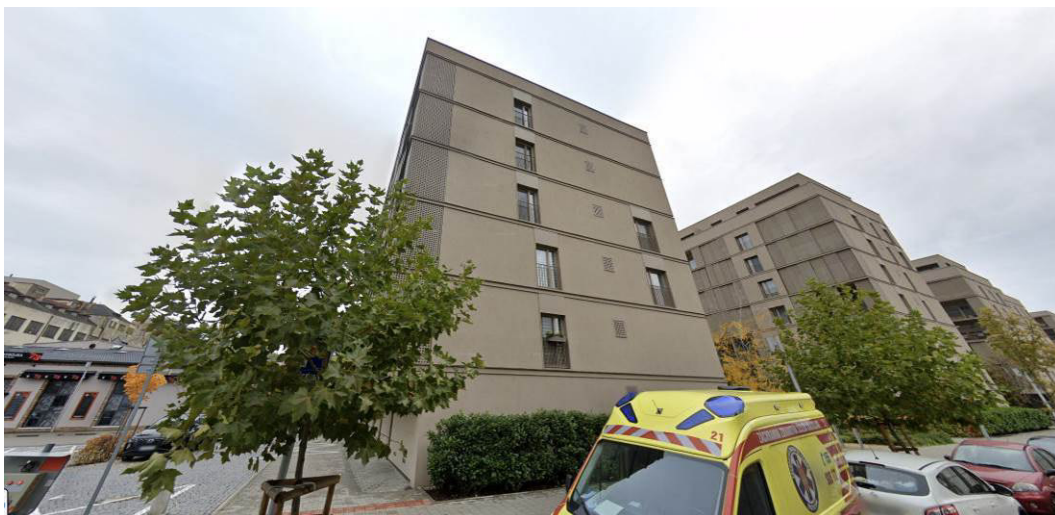
Obr. 26 výpočtový bod VB 9 vo výške 15 m v mieste bytov pred fasádou polyfunkčného domu na Kominárskej 24C v Bratislave ( podklad : www.google.com/maps )
