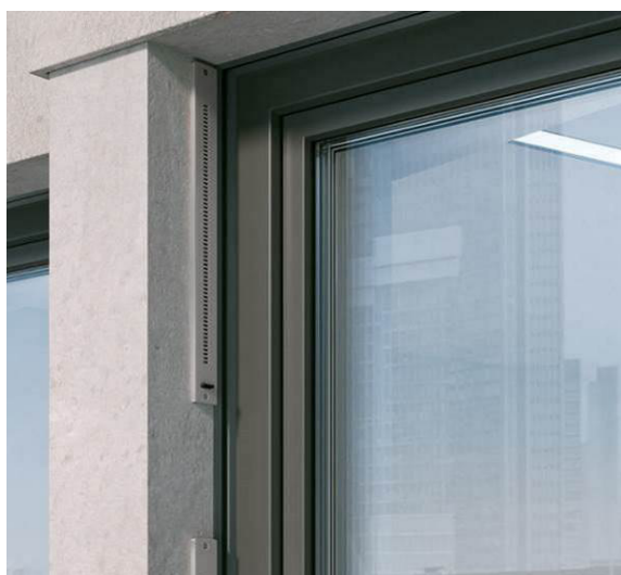
Obr. 33 příklady aktivních vetracích prvků určených na montáž do obvodového pláště (Siegenia, Systemair, Elektrodesign, Lunos, Dalap, Zender, Schüco, Siegenenia )
