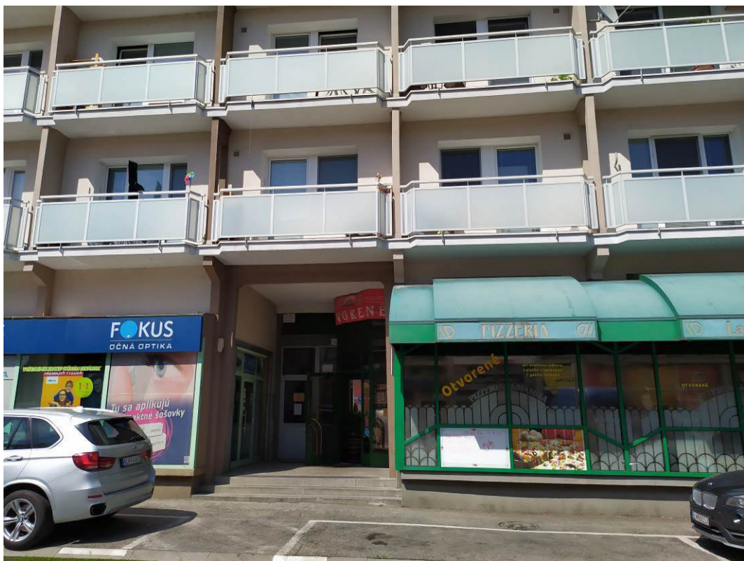
Obr. 22 výpočtový bod VB 5 vo výške 5 m v mieste bytov pred fasádou polyfunkčného domu na Škultétyho 10 v Bratislave
