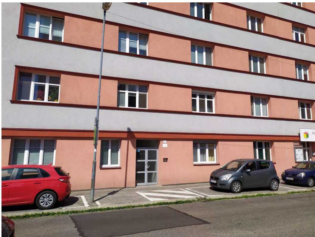
Obr. 21 výpočtový bod VB 4 vo výške 5 m v mieste bytov pred fasádou polyfunkčného domu na Škultétyho 4 v Bratislave
