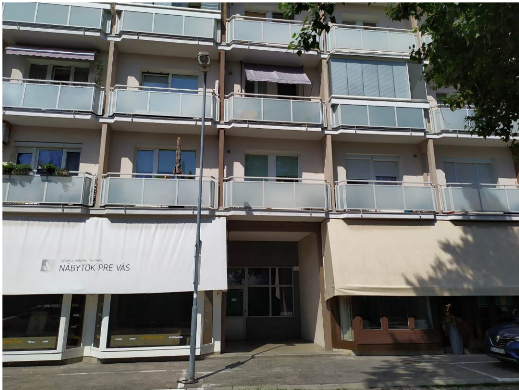
Obr. 23 výpočtový bod VB 6 vo výške 5 m v mieste bytov pred fasádou polyfunkčného domu na Škultétyho 16 v Bratislave
