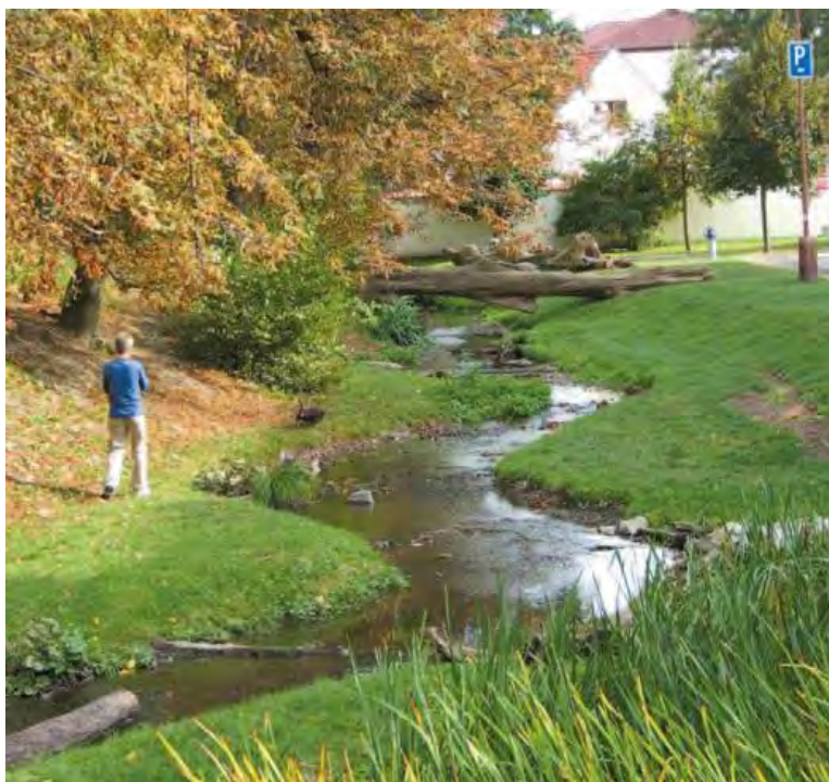
Obr. 11.1 Príklad lokálneho opevnenia kynetky kameňmi (prevzaté z Unie pro řeku Moravu, 2009)
