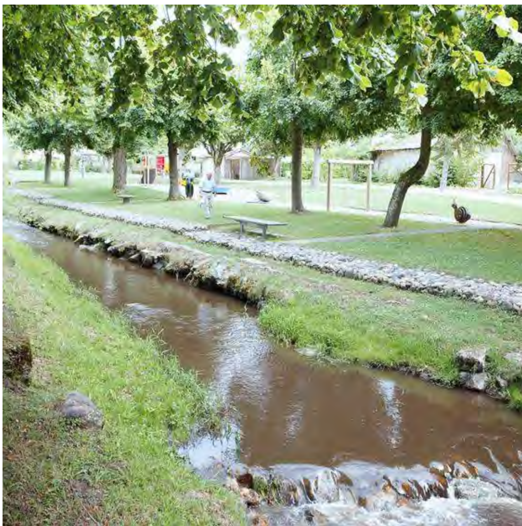
Breh stabilizovaný uloženými kameňmi a trávou
