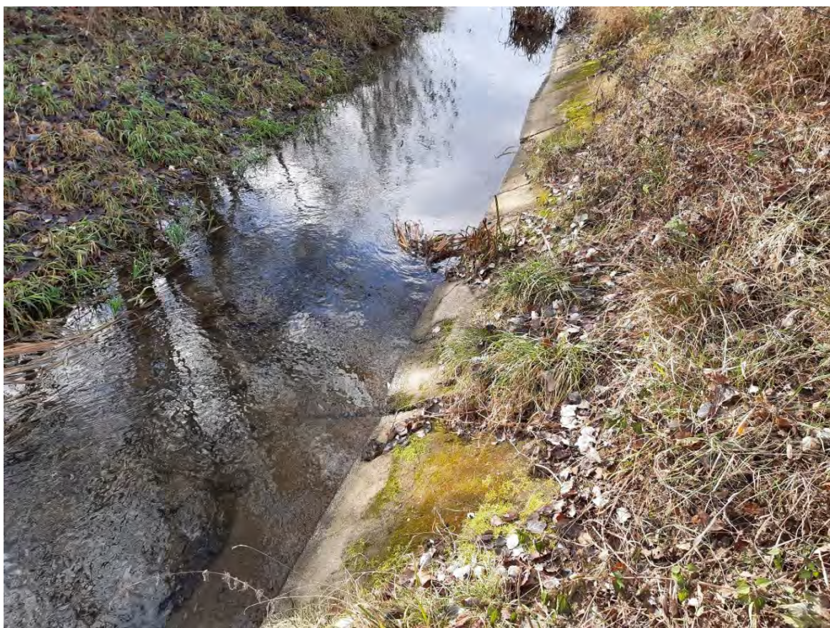
Dolná časť svahov brehov je opevnená netónovými panelmi
