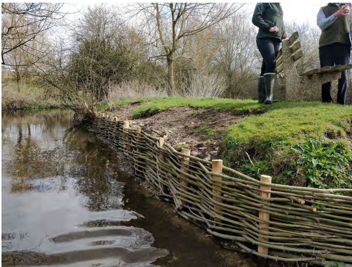
Opevnenie brehu zápletovým plôtikom
