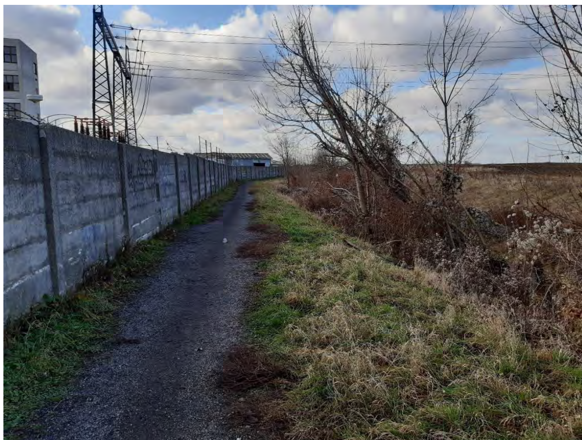
Chodník na ľavom brehu. Nadväzný úsek po prúde od ústia Paseckého potoka.
