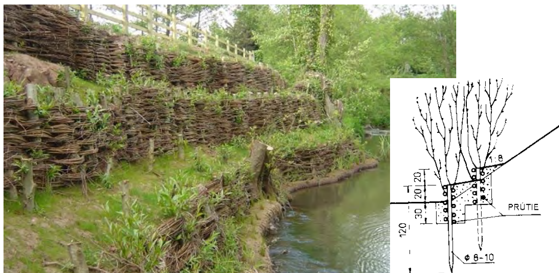
Obr. 11.3 Príklad opevnenia svahu koryta viacradovým pleteným vrbovým plôtikom (detail prevzatý z NOVÁK, L. a kol., 1986)
