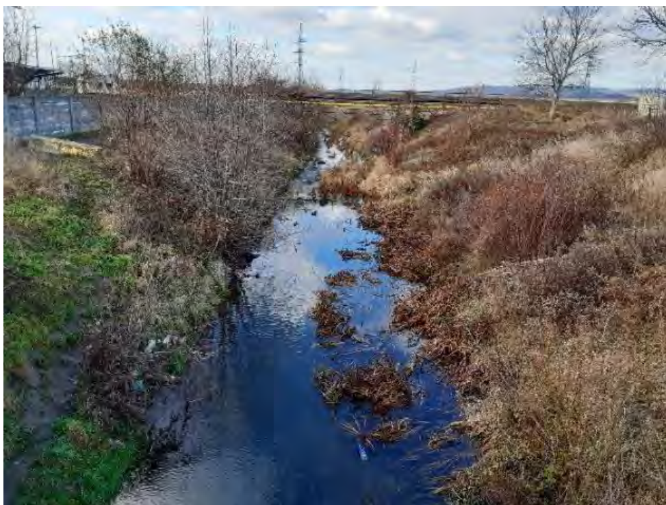
Obr. 5.2 Pohľad na súčasný stav upraveného a napriameného koryta Teplice v záujmovom území
