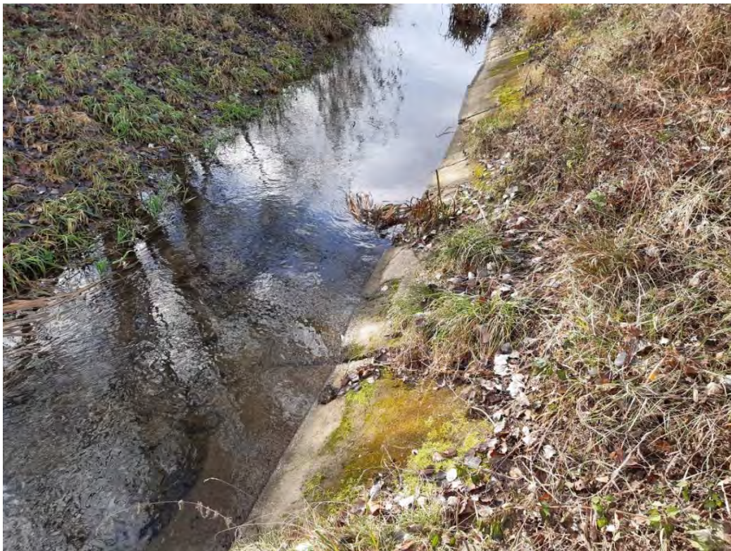
Obr. 5.6 Brehy lichobežníkového koryta Teplice, opevnené betónovými prefabrikovanými doskami – významne zmenený vodný útvar so zlou hydromorfologickou kvalitou
