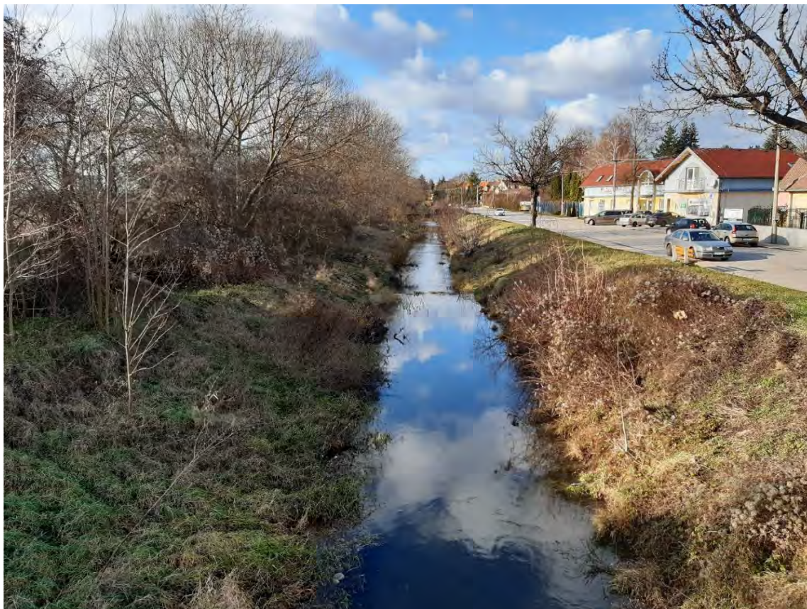
Obr. 5.7 Napriamené silne upravené koryto Teplice pozdĺž ulice Kolónia
