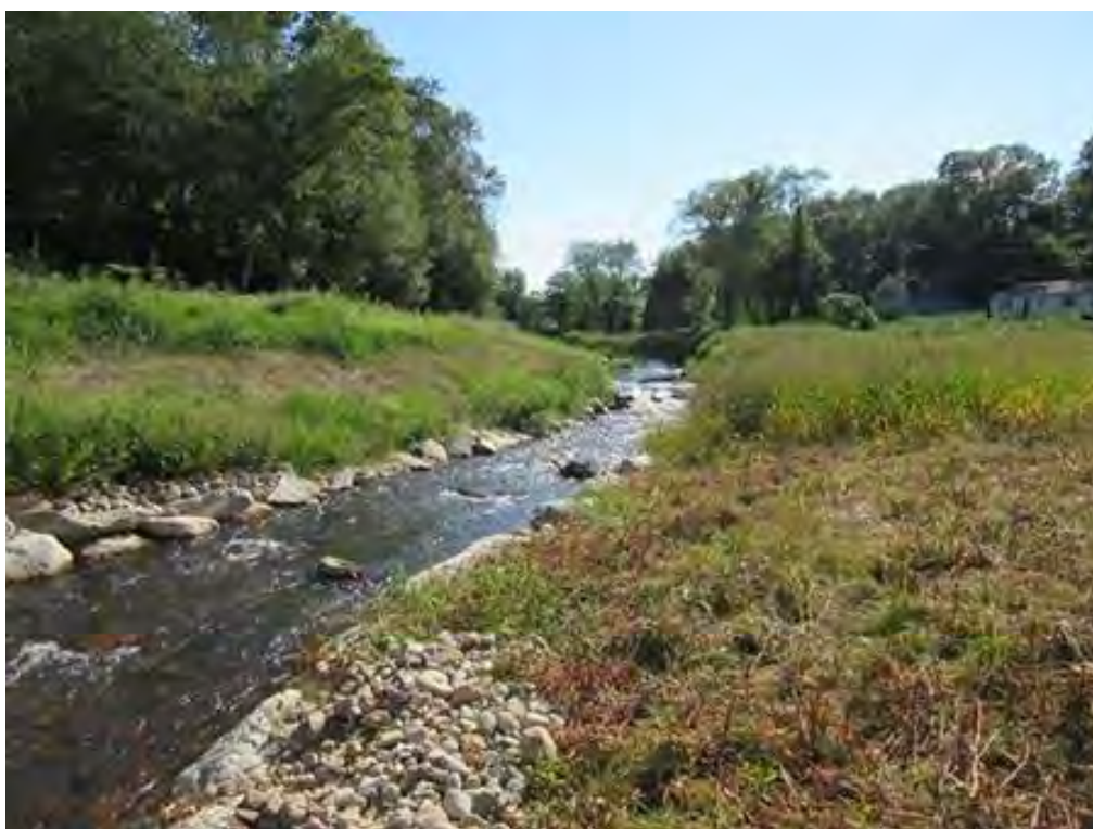
Breh stabilizovaný pätkou z citlivo uložených kameňov a štrku
