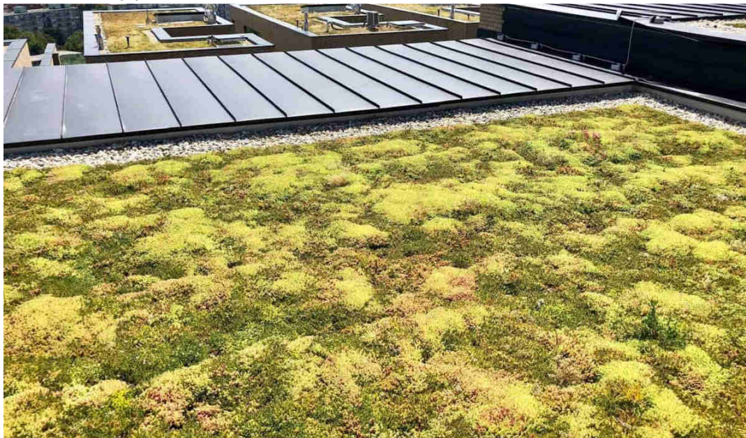
Obr.: Ilustračný pohľad na extenzívnu strešnú zeleň
