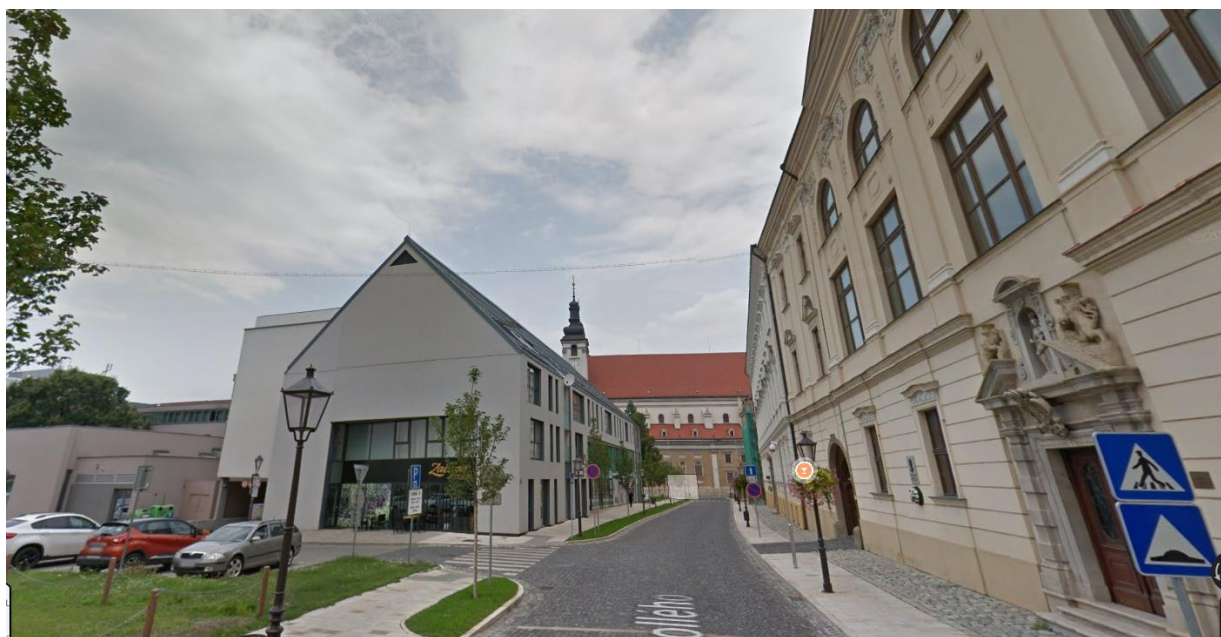
Obrázok 31 - Komplex Leonardo a pohľad na vjazd do garáže z Hollého ul.
