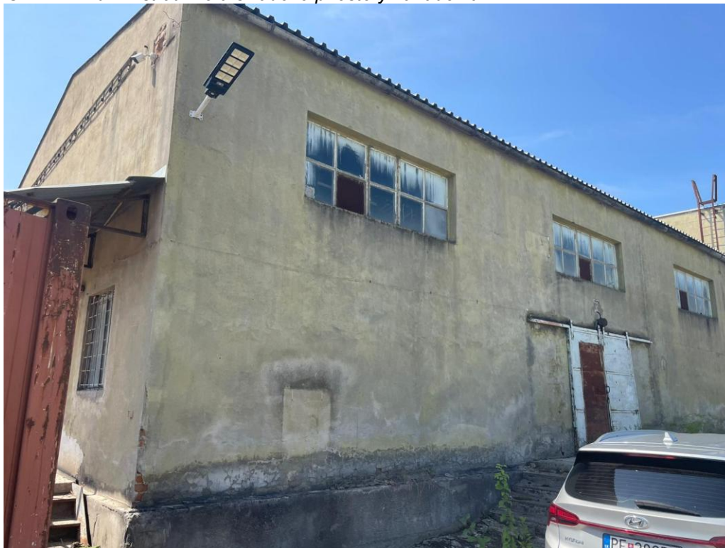
Obr. č. 2 Administratívne a skladové priestory zariadenia
