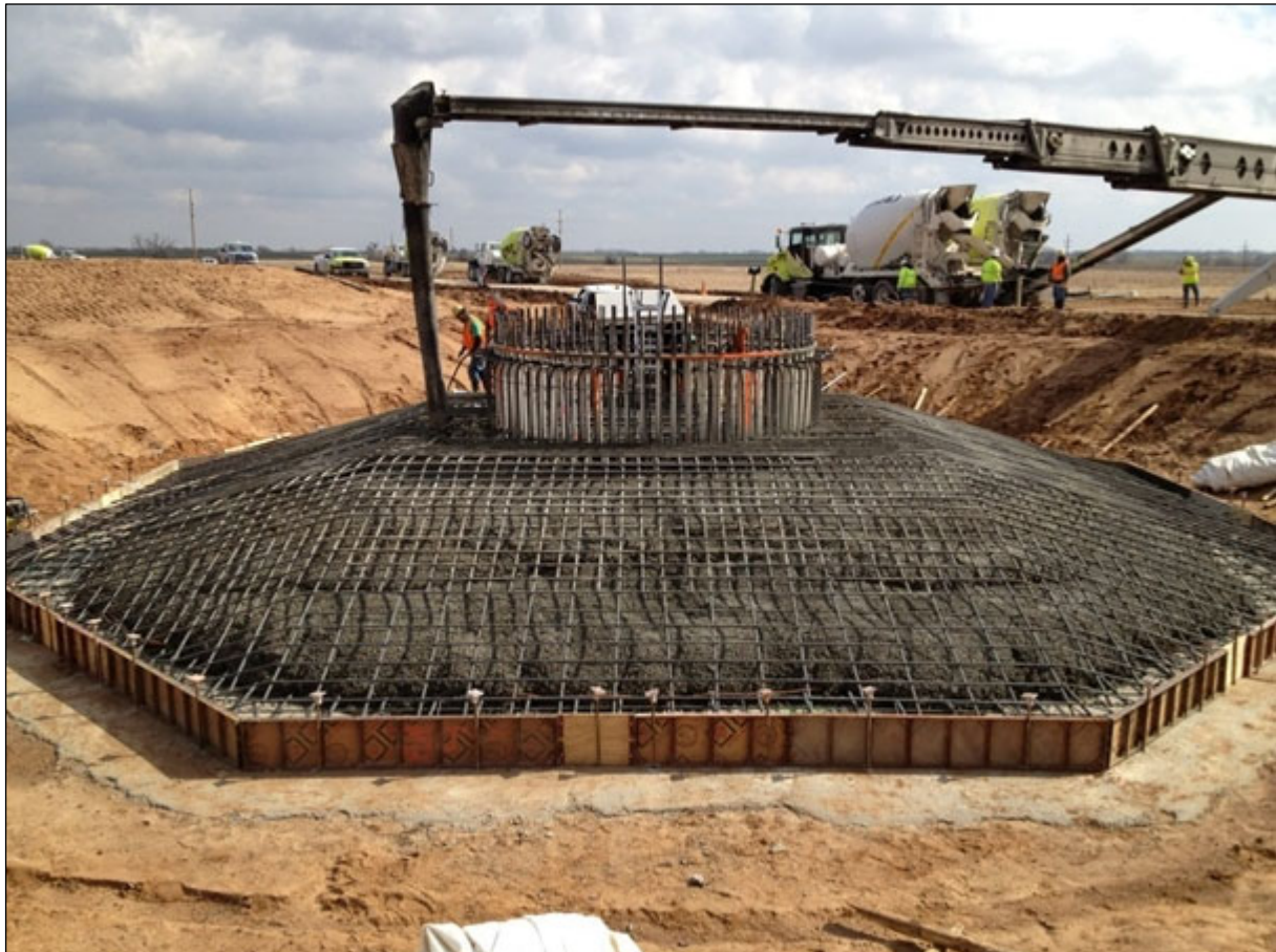
Obrázok 8: Teleso základov veternej elektrárne z armovaného betónu
