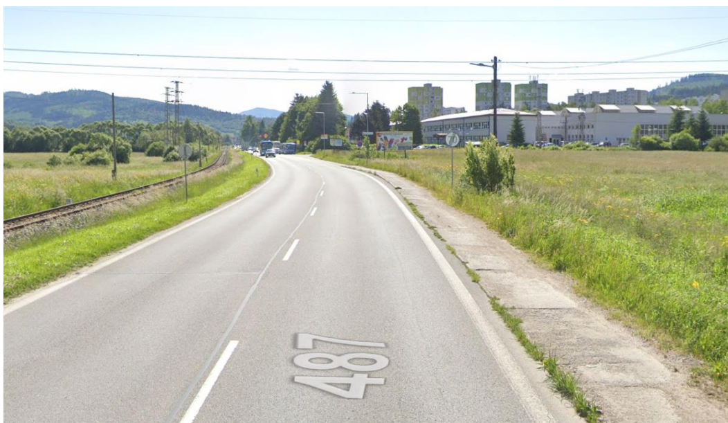
Obr. 2.4 – Pohľad na cestu II/487 (GoogleMaps)
